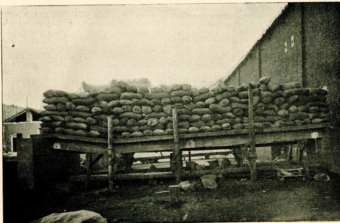
Fig. 30. — Trave armata senza staffe sottoposta al carico di rottura di 9400 kg.
