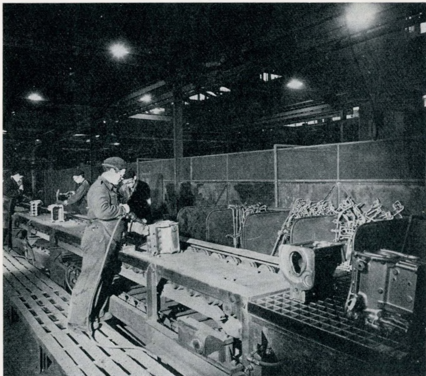
Fig. 7 - Fonderia ghisa Fiat Mirafiori: convogliatore apron per sbavatura monoblocchi.
