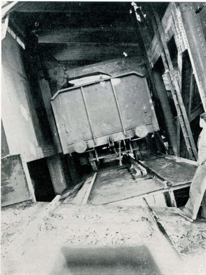
Fig. 13 - Rovesciatore carro ferroviario.
