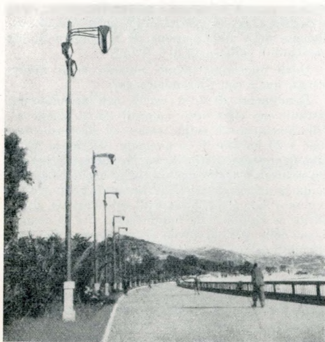
Fig. 5 - Impianto con fluorescenza a Sanremo, per illuminazione normale e illuminazione di gala (lampade superiori).
