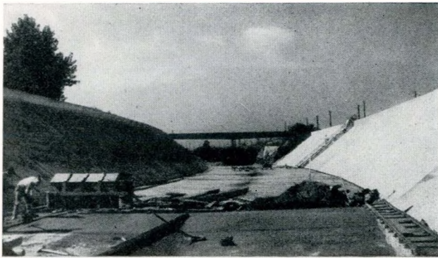
Fig. 7 - Canale derivatore in prossimità della centrale.
