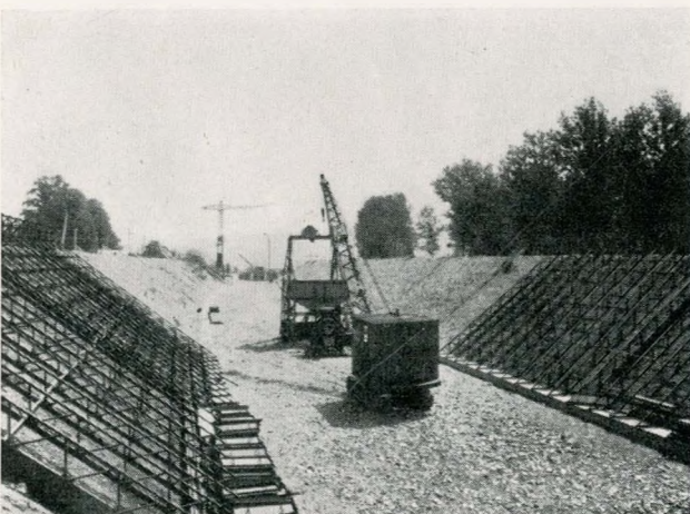
Fig. 23 - Esecuzione del rivestimento del canale derivatore.
