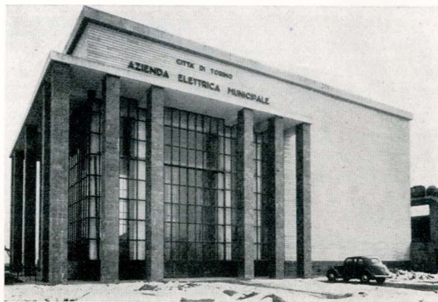
Fig. 11 - Vista esterna della centrale.
