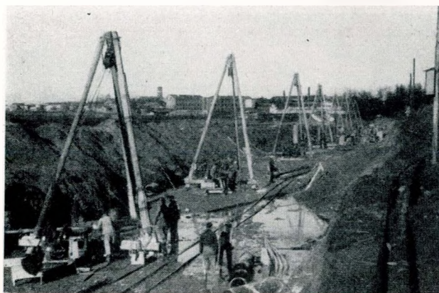
Fig. 19 - Costruzione della paratia subalvea.
