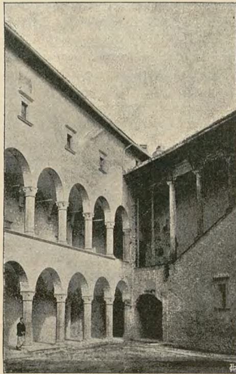
Fig. 122. Cortile nel Castello di Bracciano.
