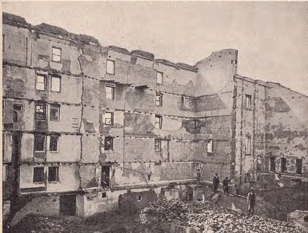
Fig. 55. — Il muro di sinistra del teatro Sociale di Rovigo dopo l'incendio.
