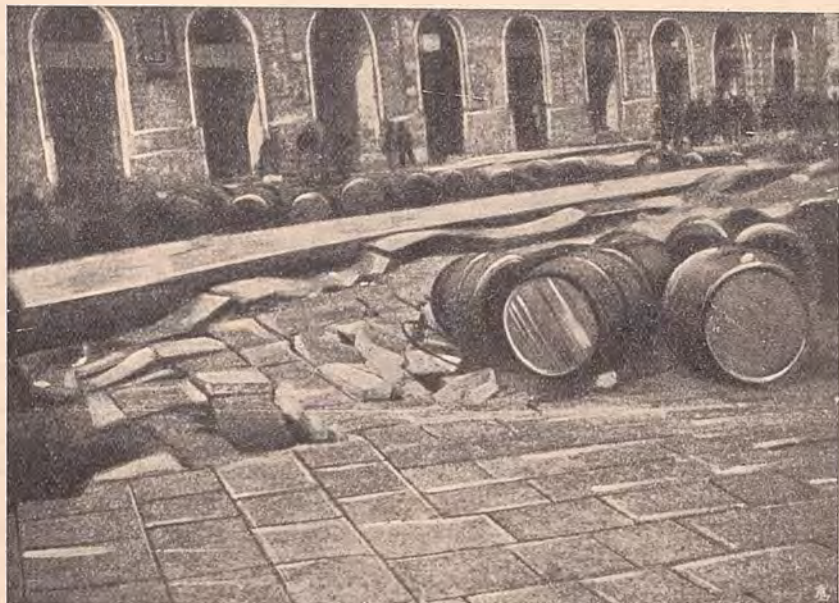
Fig. 108. — Onde gravifiche fissate dal lastricato della Marina di Messina per il terremoto del 28 dicembre 1908.
