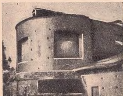
Fig. 120. — Abside del Duomo di Reggio rimasta intatta nel terremoto del 28 dicembre 1908.
