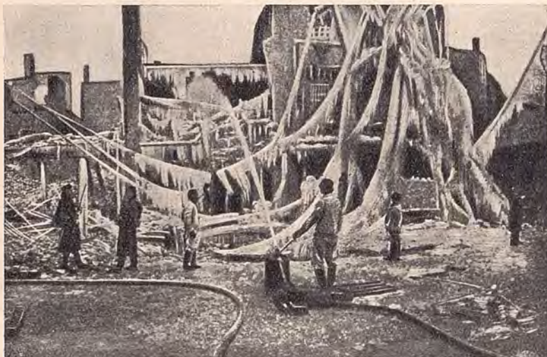
Fig. 51. — Effetti del gelo durante l'estinzione di un incendio. Le condutture elettriche sono piegate e spezzate dal getto delle pompe.
