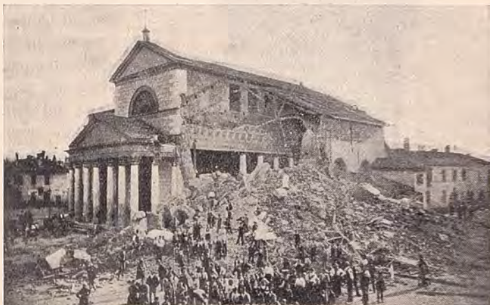
Fig. 91. — Macerie del caduto Campanile di Corbetta (2 giugno 1902).
