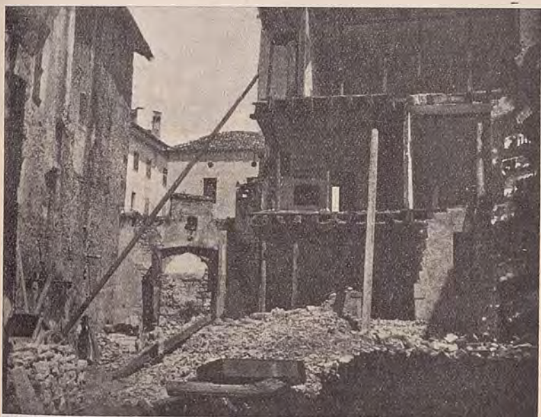
Fig. 104. — Effetti del terremoto del 1873 a Belluno.
