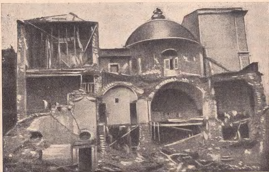
Fig. 119. — Chiesa di S. M. Arena, in Messina (terremoto del 28 dicembre 1908). Le facciate abbattute lasciano le stanze allo scoperto. La cupola è intatta.
