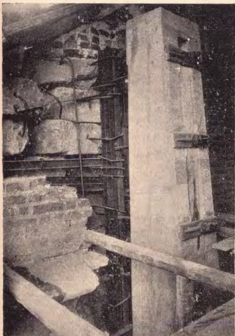
c) Uno dei contrafforti, al quale sono ancorati, per mezzo di tiranti di ferro, i conici del frontone. Girando i dadi a vite sulle piastre, si può più o meno tirare il frontone verso i contrafforti.
