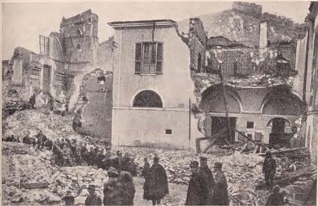
Fig. 106. — Terremoto del 13 gennaio 1915 a Sora.
