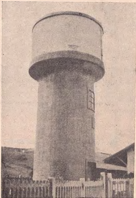
Fig. 121. — Serbatoio d'acqua della stazione ferr. di Rocchetta S. Antonio.
