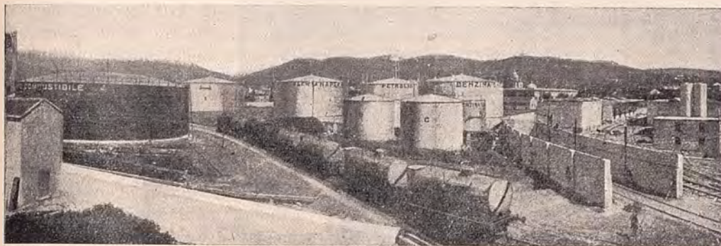
Fig. 81. — Veduta dei serbatoi di benzina e petrolio della Società «Nafta» a Vado Ligure.
