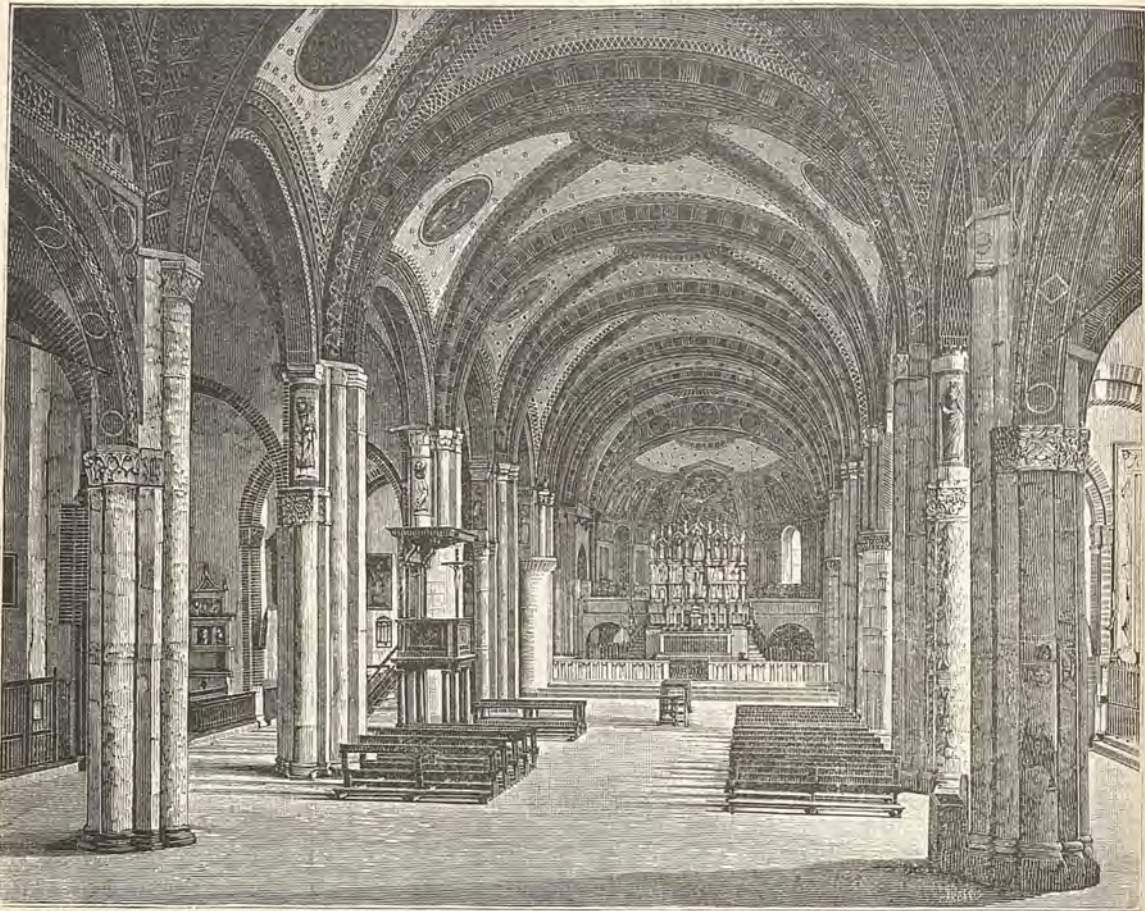
Fig. 1152. — Interno della Basilica di Sant'Eustorgio a Milano (da fotografia BROGI).
