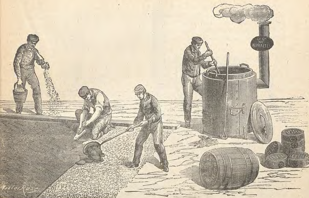
Fig. 44. — Pavimentazione con asfalto.
