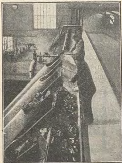
Fig. 1290. — Sistema di caricamento dei forni Horsfall.
