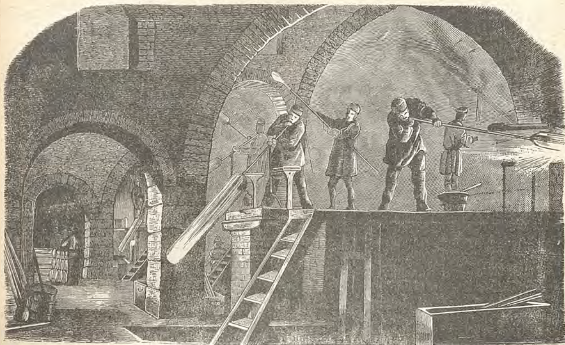
Fig. 234. - Soffiatura dei cilindri per lastre di vetro.
