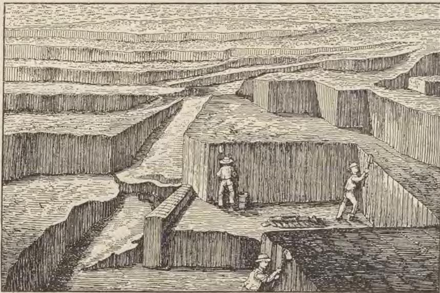
Fig. 292. — L'attacco del terreno per la cavatura delle argille.
