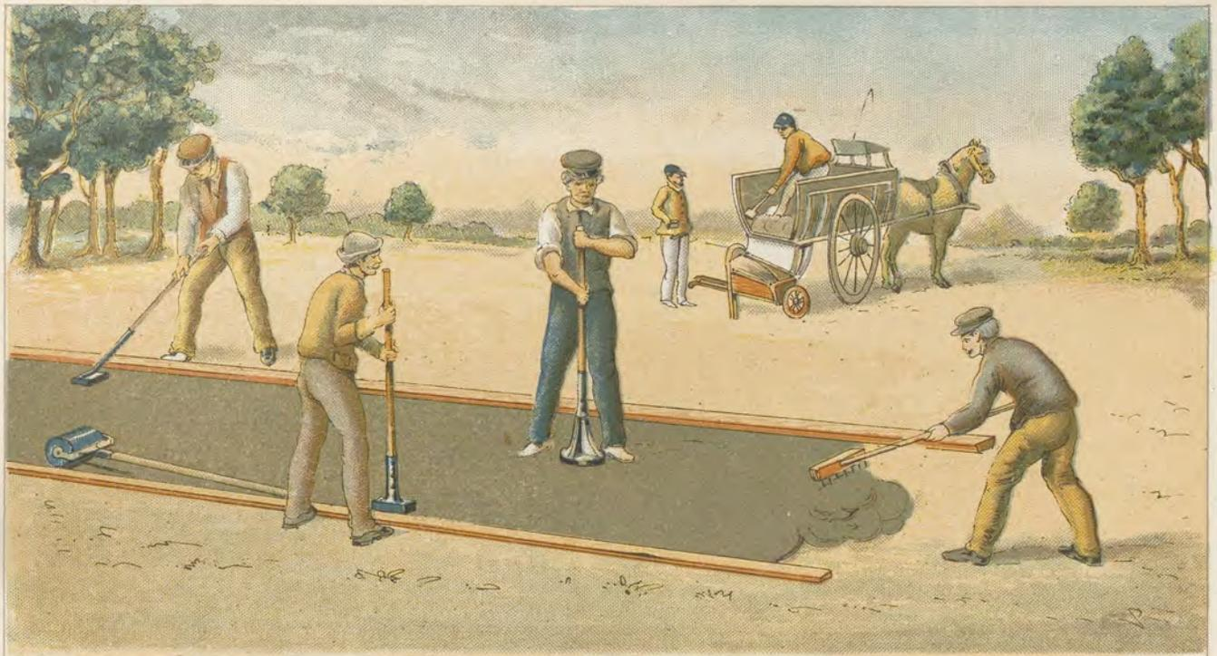
FIG. 1 *La posa in opera dell'asfalto compresso*
