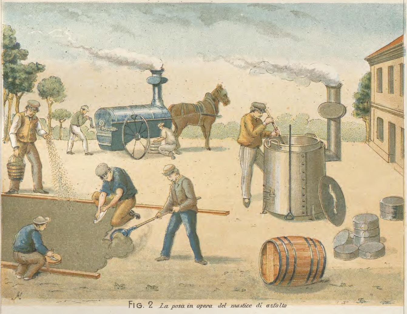
FIG. 2 *La posa in opera del mastice di asfalto*
