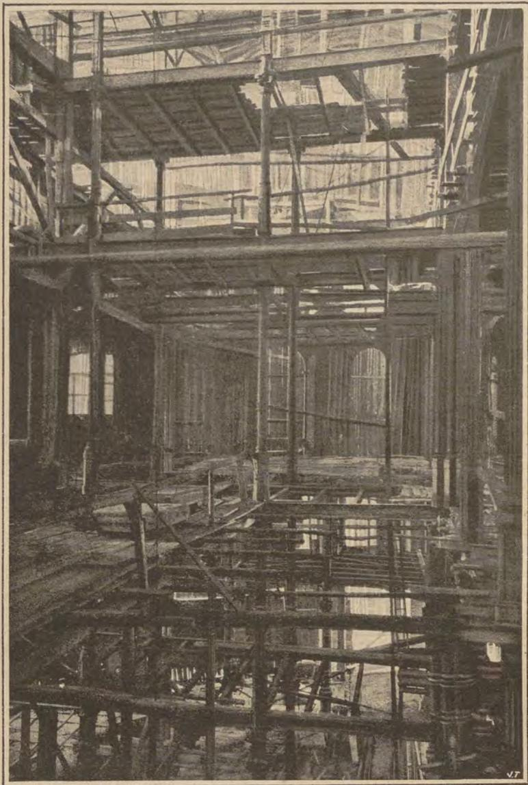
Fig. 1. — Veduta dell'ossatura metallica durante la costruzione.
