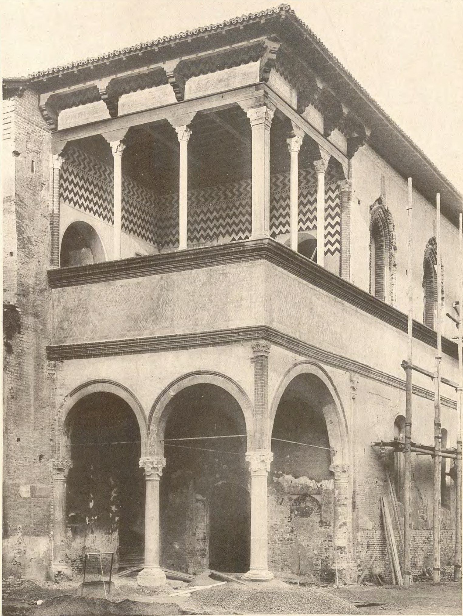
(Fotogr. dello Stab. A. Ferrario, — Milano).
