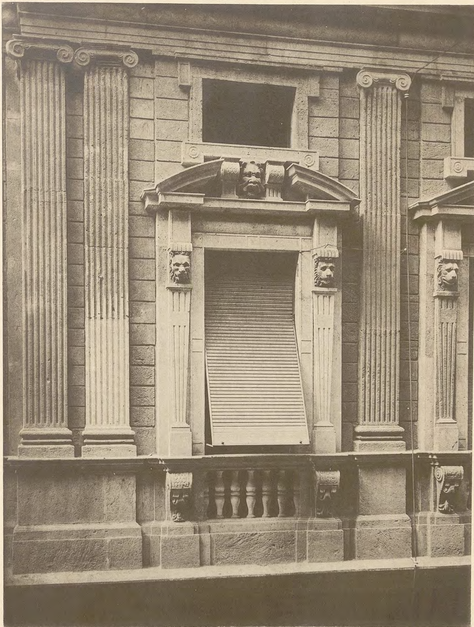
PARTICOLARI DEL I.º PIANO DELLA FRONTE VERSO PIAZZA S. FEDELE, RESTAURATA NEL 1893-94.
