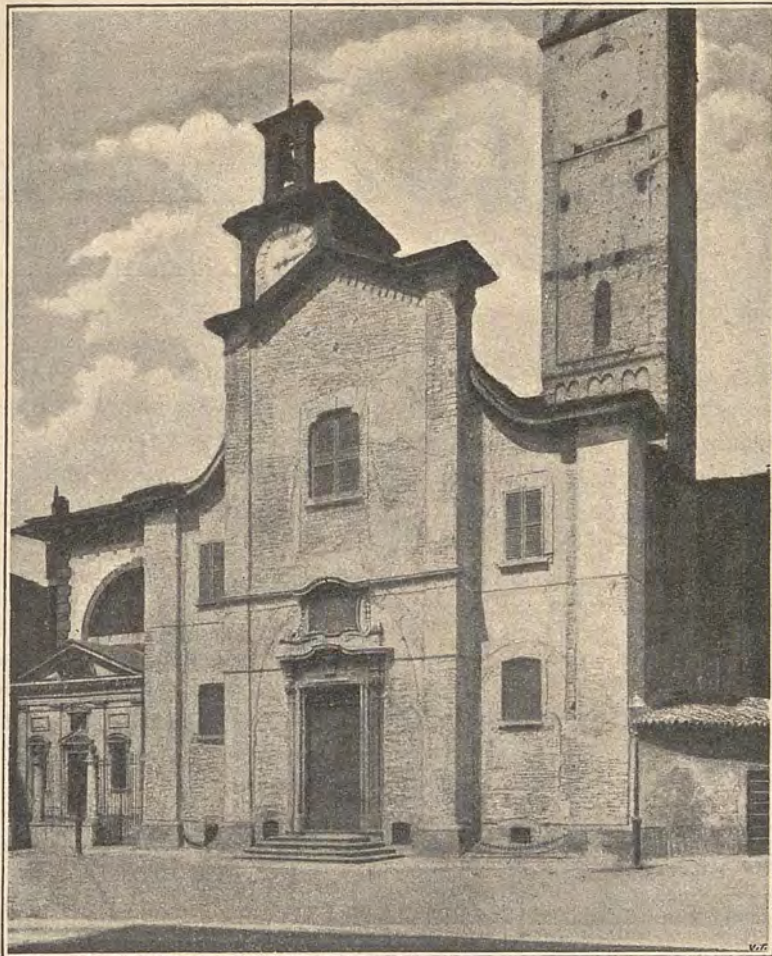
Facciata della Chiesa di S. Sepolcro, prima del restauro.
