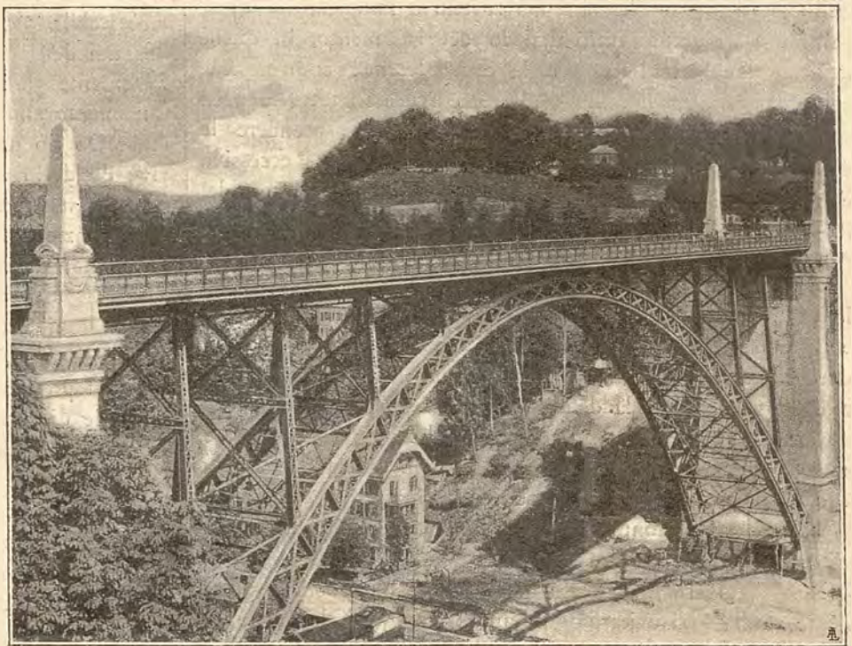
Dettaglio della campata centrale del ponte Kornhaus.
