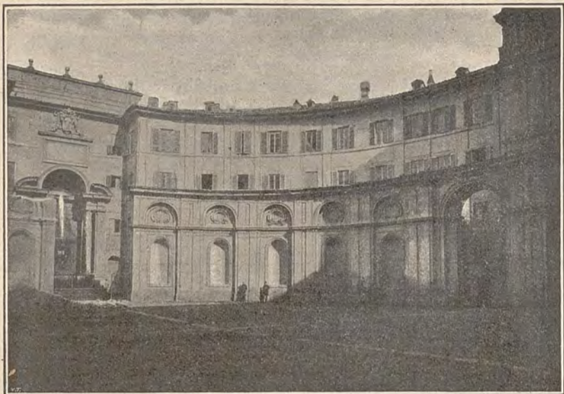
Esedra del Fontana durante i lavori di demolizione del 1870 per impiantarvi l'Aula provvisoria attuale.
