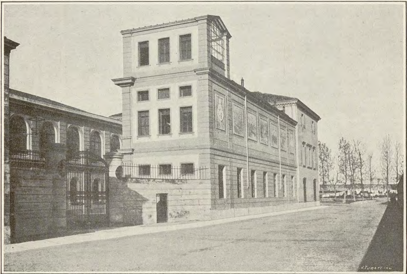
Prospetto esterno verso Via dell'Arena.
