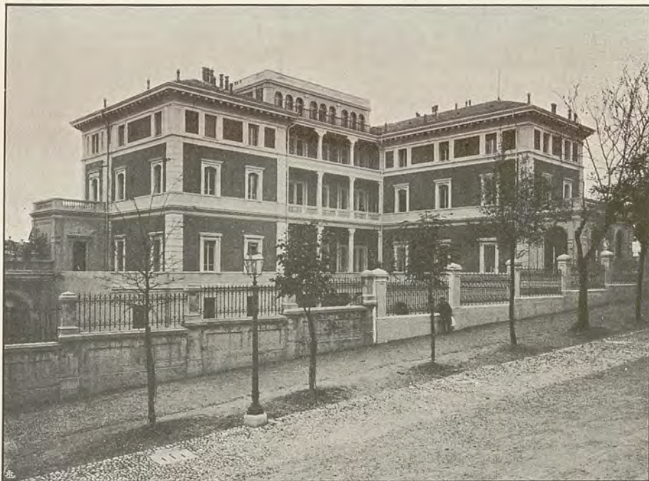
Prospetto verso la Montagnola.
