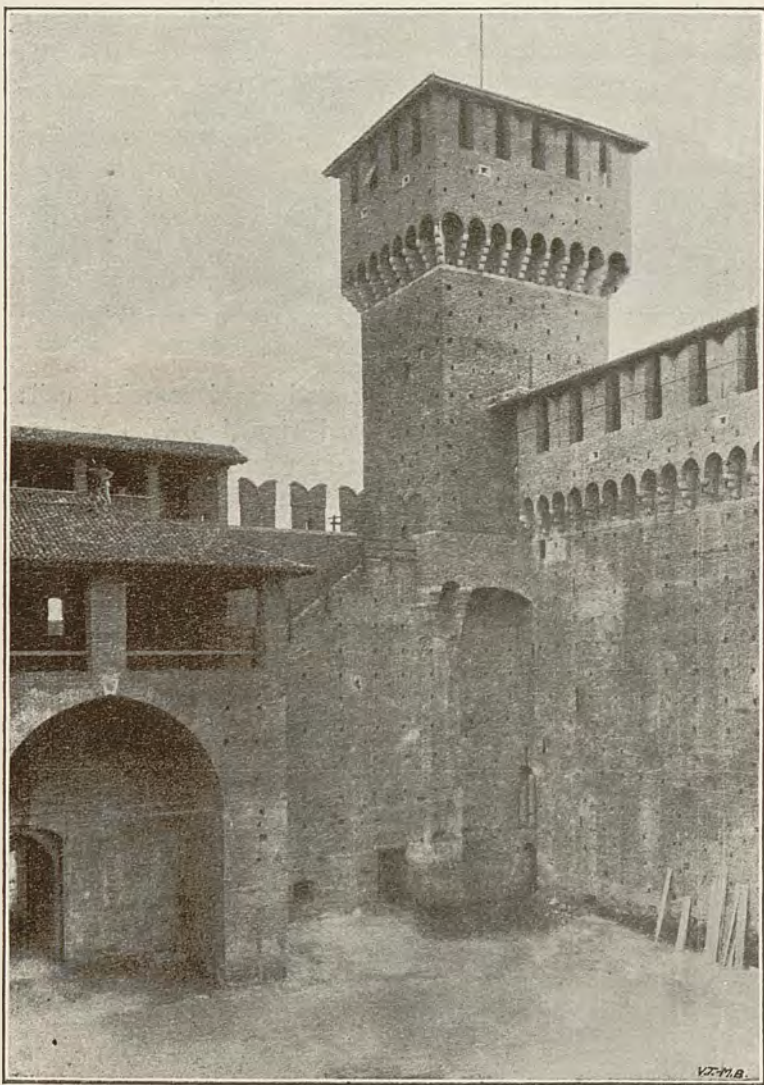
Collegamento della Corte Ducale colla Rocchetta, in corso di restauro: Anno 1899.
