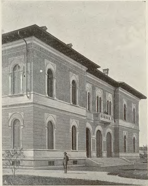
Veduta prospettica della fronte verso l'Adda.
