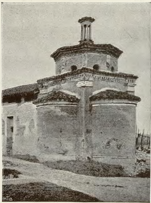
La Cappella della Cascina Pozzobonelli vista dall'esterno.
