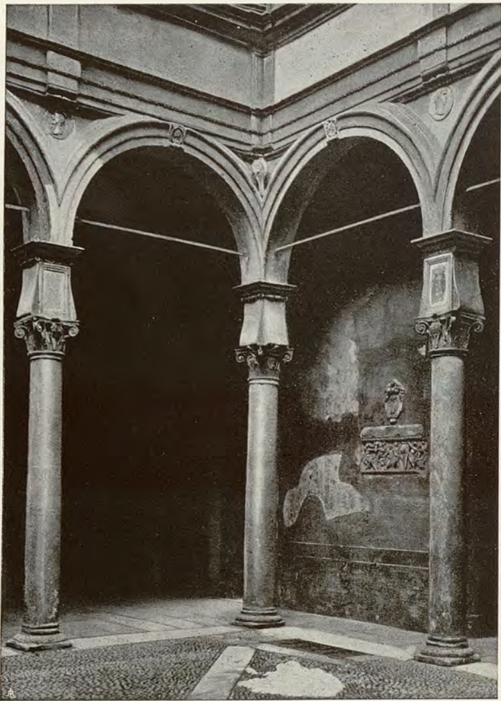
Cortile dell'ex Casa Pozzobonelli in Via dei Piatti.
