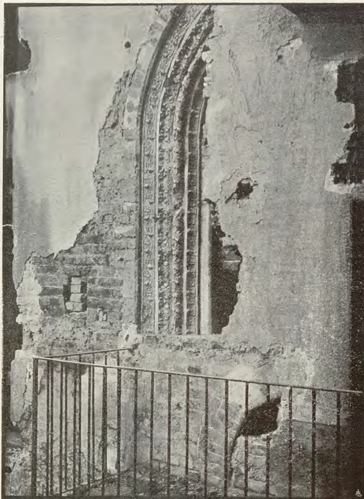
Cortile - Finestra del primo piano.
