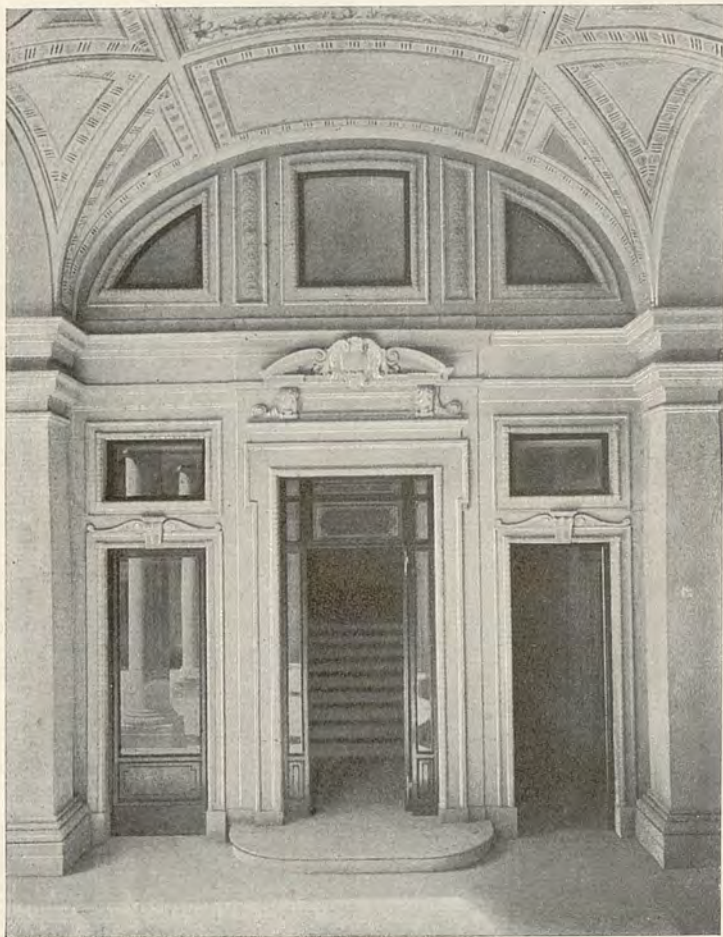
Ingresso allo scalone, sotto l'atrio.
