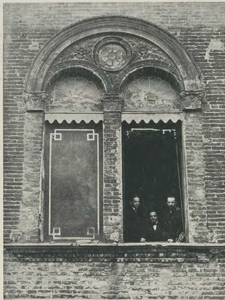
Finestra in primo piano (stato attuale).
