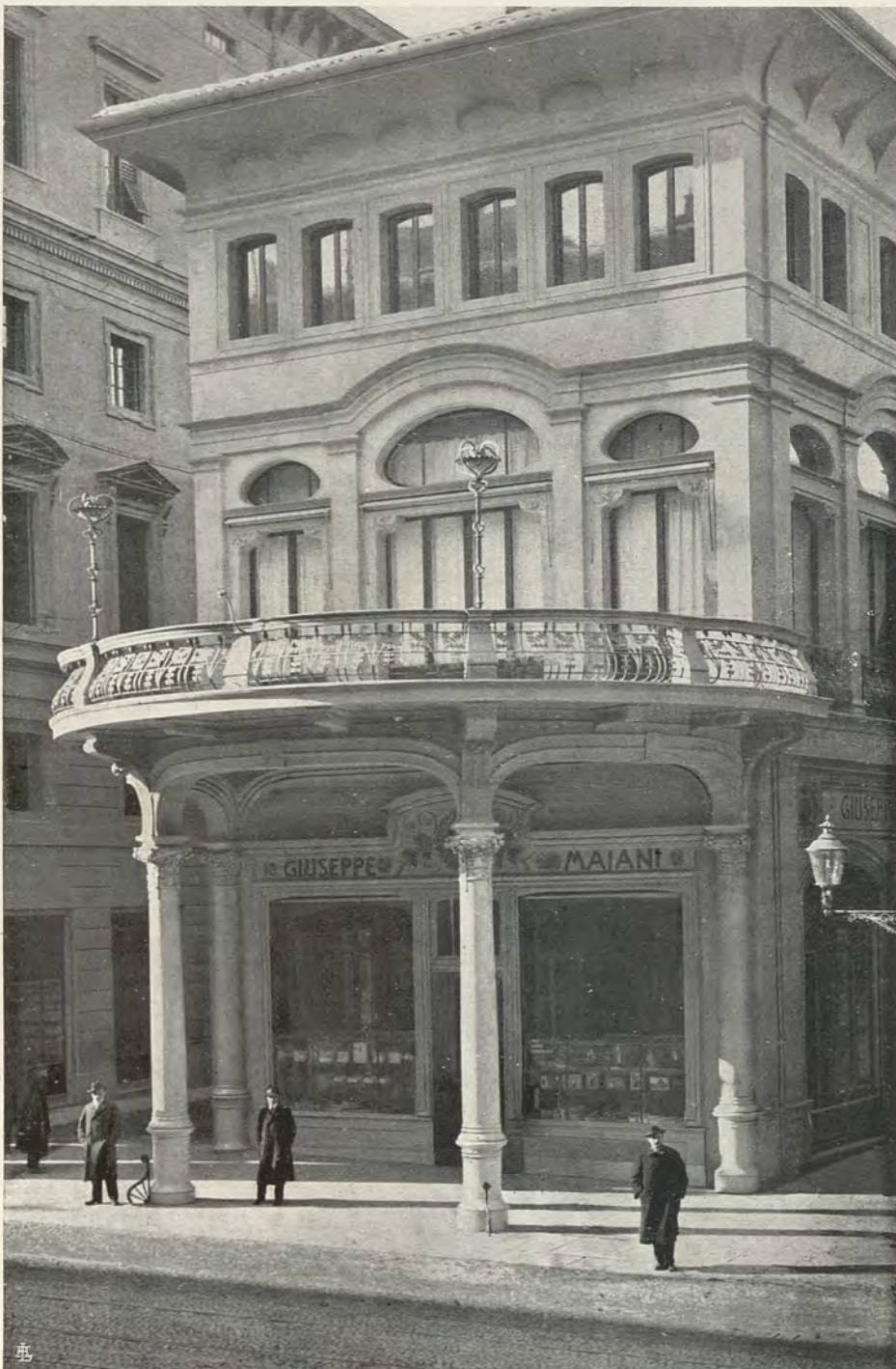
Veduta generale della Palazzina Majani.
