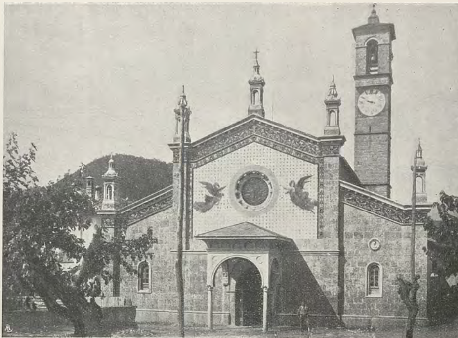
Arch. V. Muzio - La facciata dopo il restauro.
