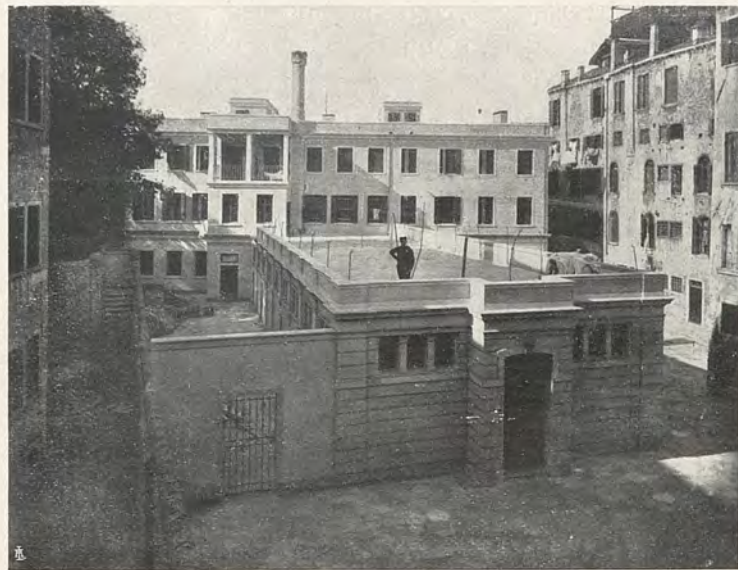
Veduta generale del fabbricato.
