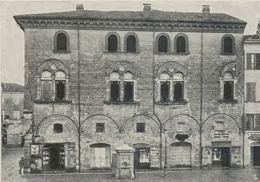
Facciata principale (stato attuale).
