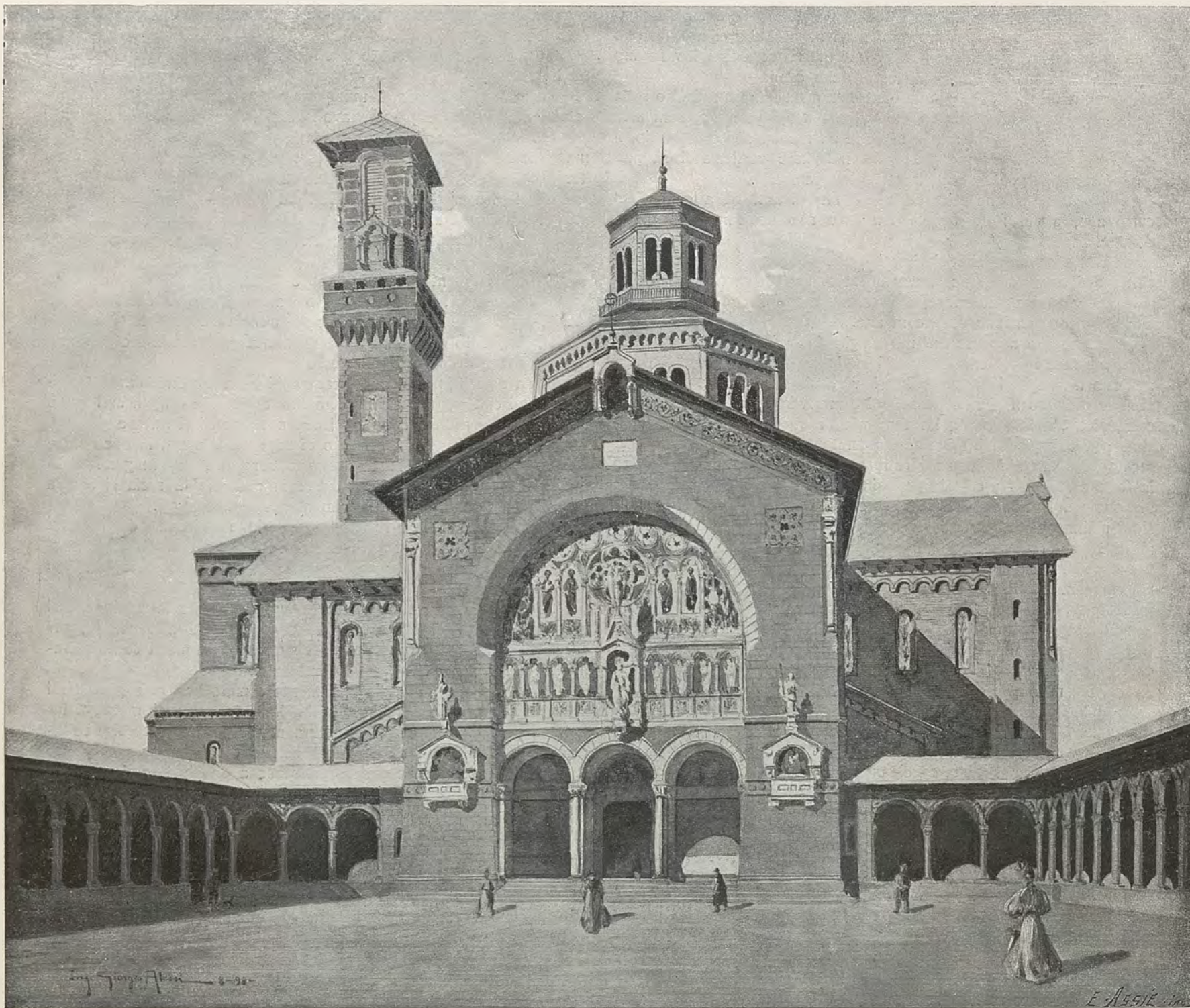
Veduta prospettica presa dal Piazzale interno.
