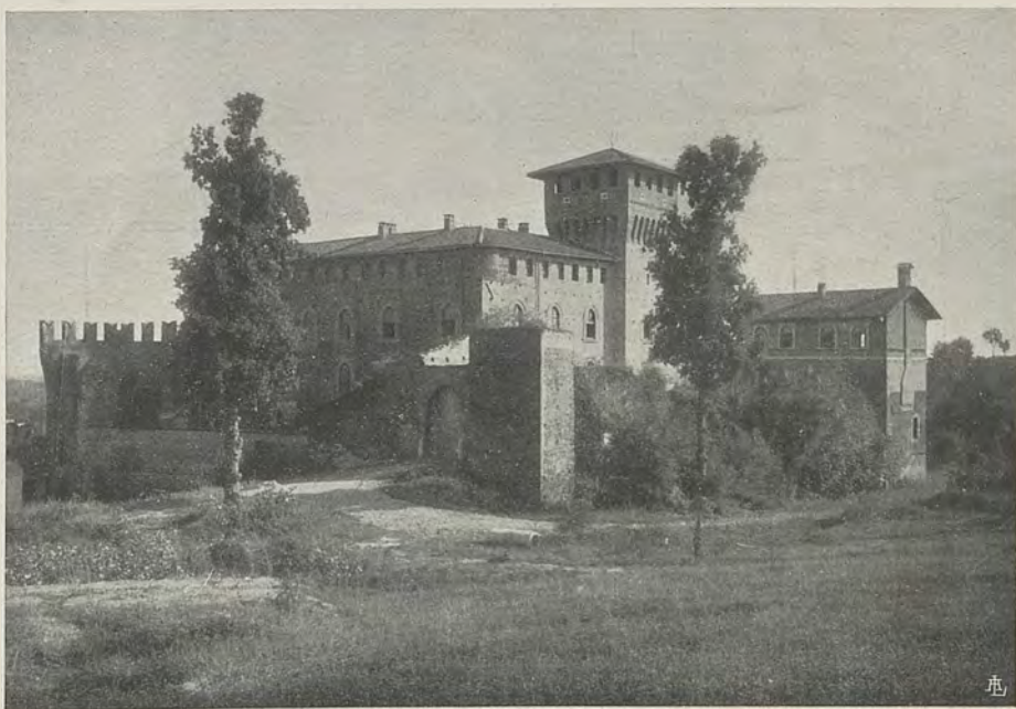
Il Castello di Barengo dal lato ovest, con veduta della casa del custode.
