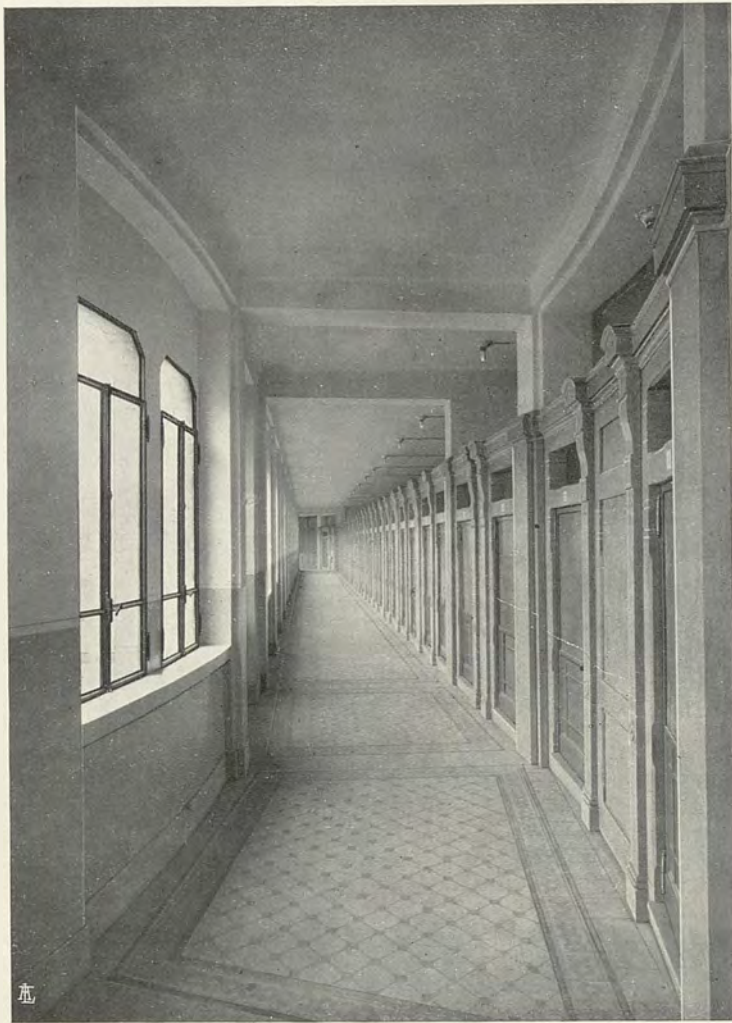
Corridoio d'accesso ai camerini dei bagni.
