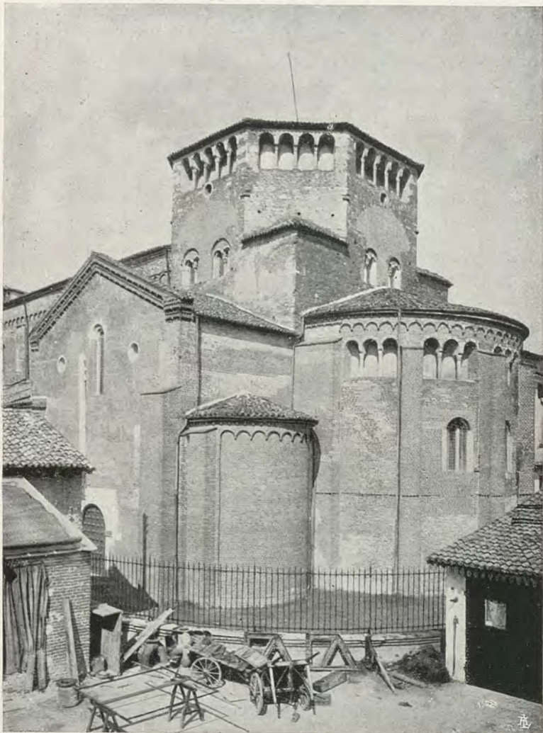
Veduta esterna delle absidi e della cupola.
