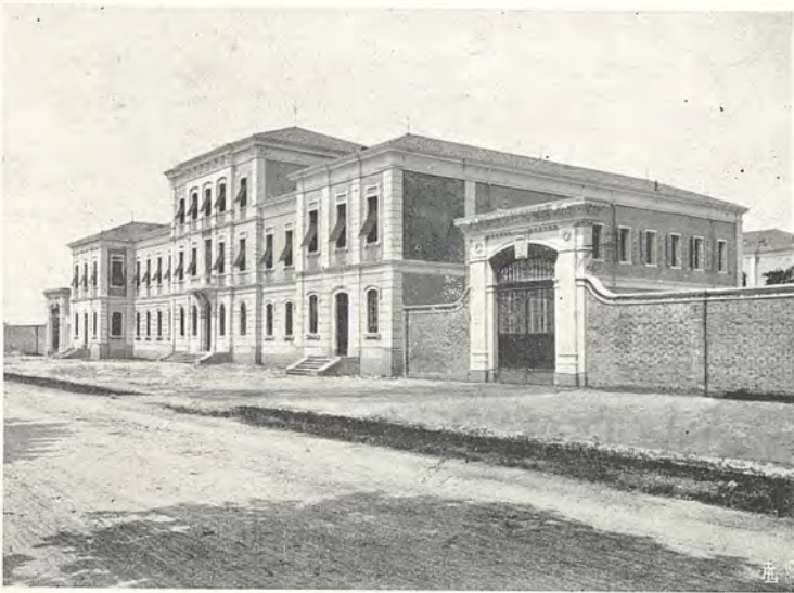
Prospetto del palazzo della Direzione
