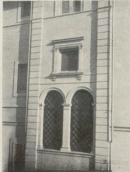
Dettaglio della finestra in corrispondenza alla scala.
