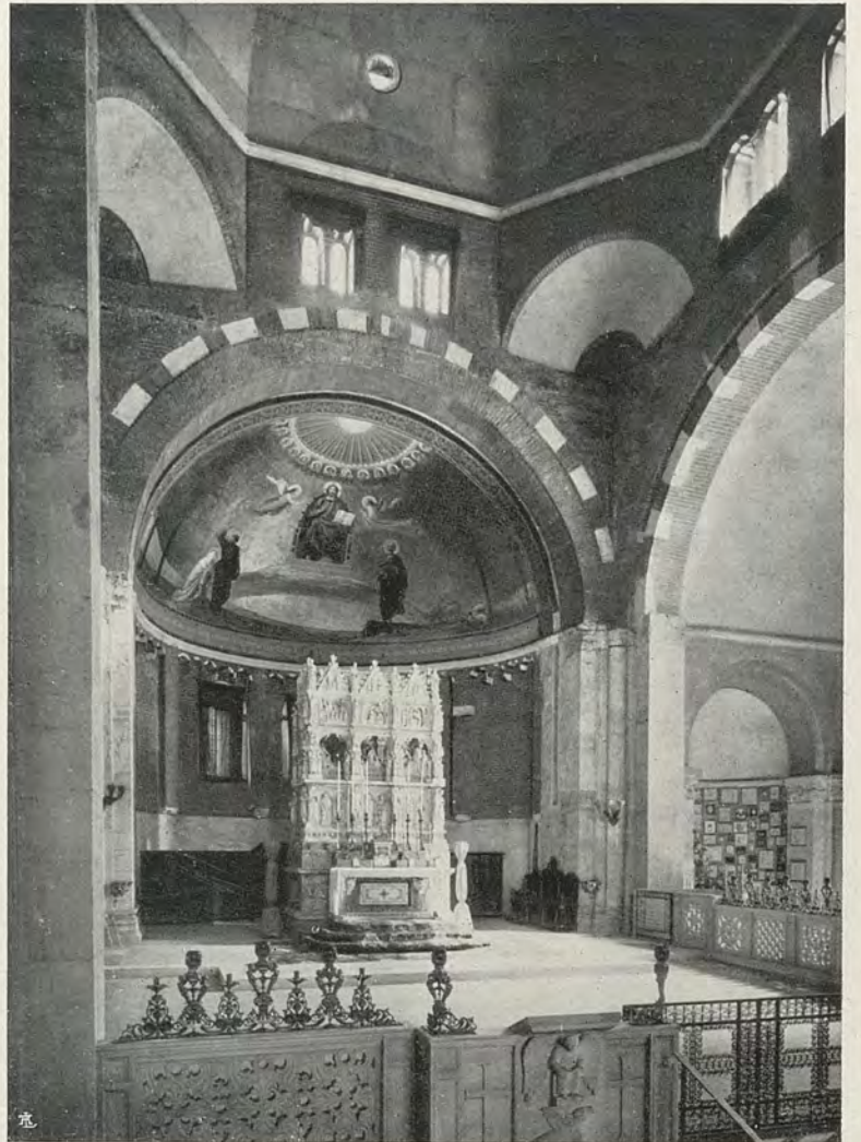
Veduta interna dell'abside centrale.
