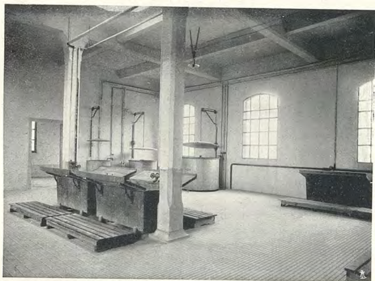
Il locale delle vasche delle lavanderie
