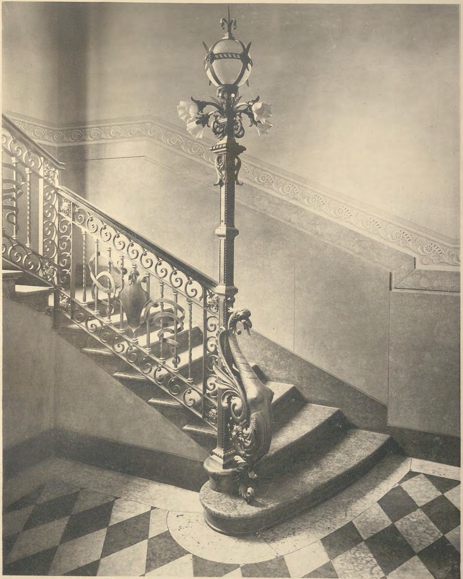
Tav. III. — La prima rampa di scala.
