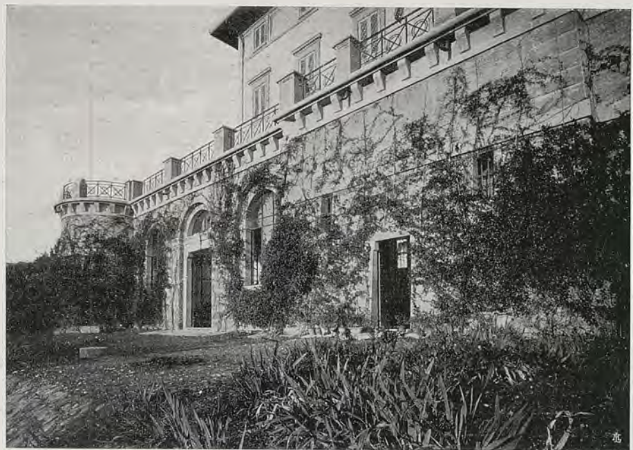
Veduta del muraglione sotto la grande terrazza.
