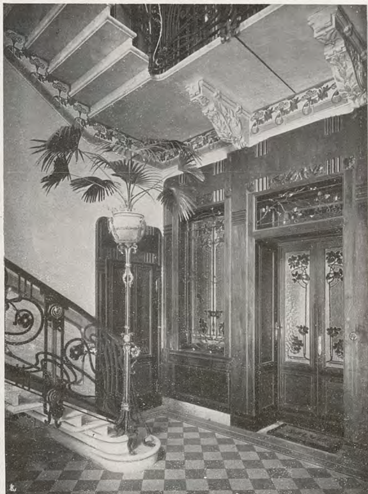
Veduta dello scalone.
