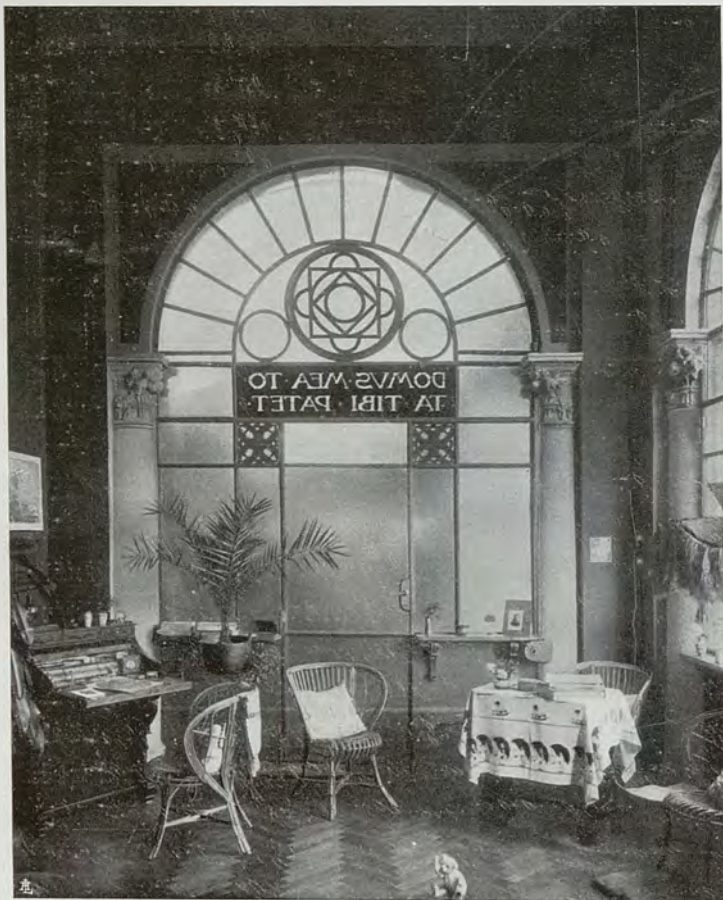
Interno della veranda.
