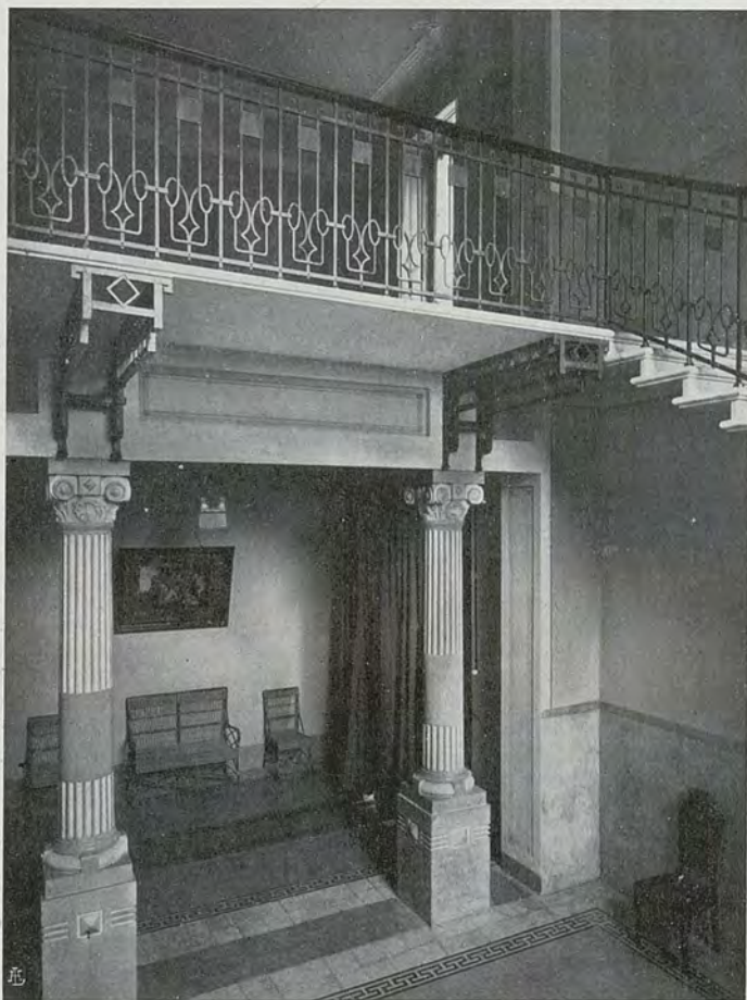
Veduta del vestibolo e dello scalone.
