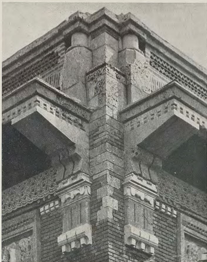
Il cornicione di gronda.
