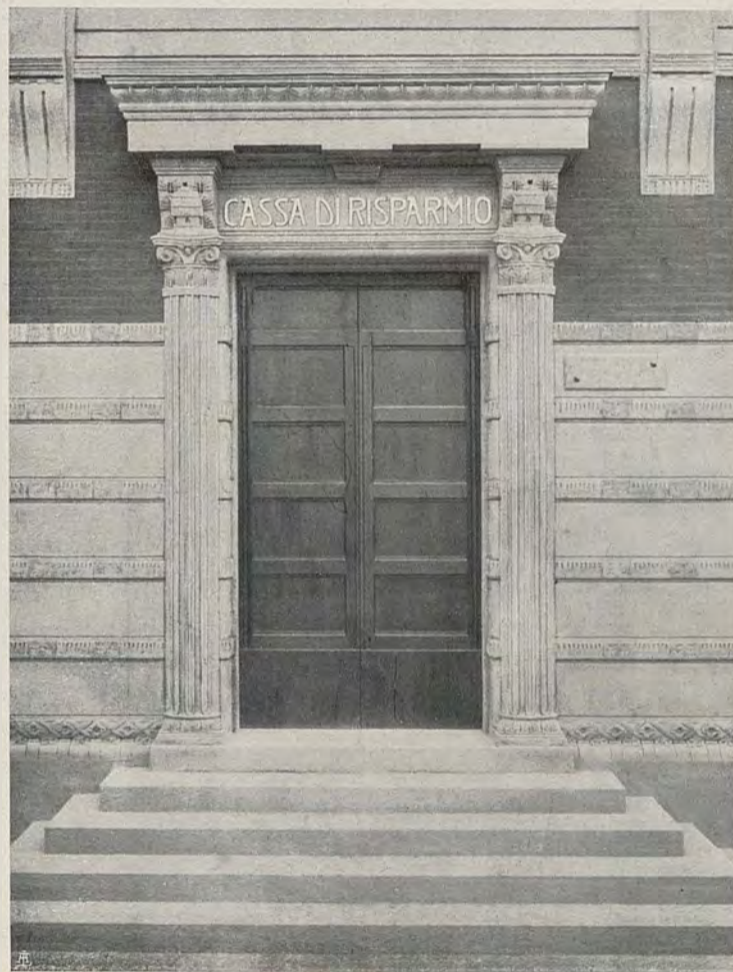
Dettaglio del portale d'ingresso.
