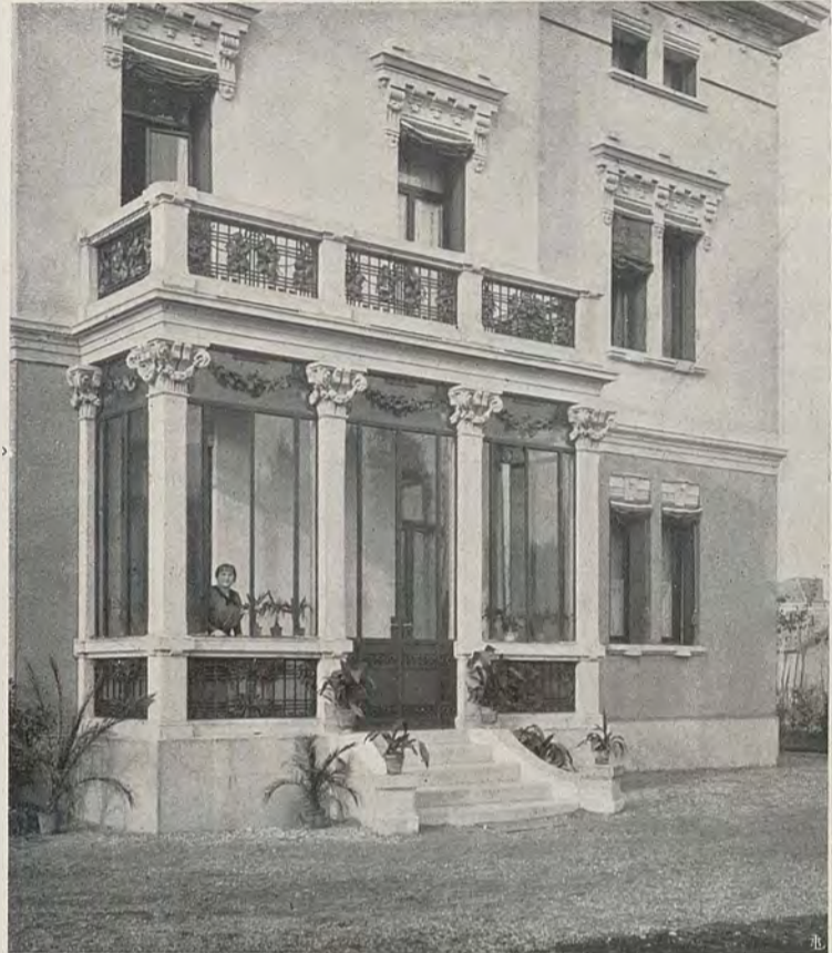
Dettaglio della veranda.
