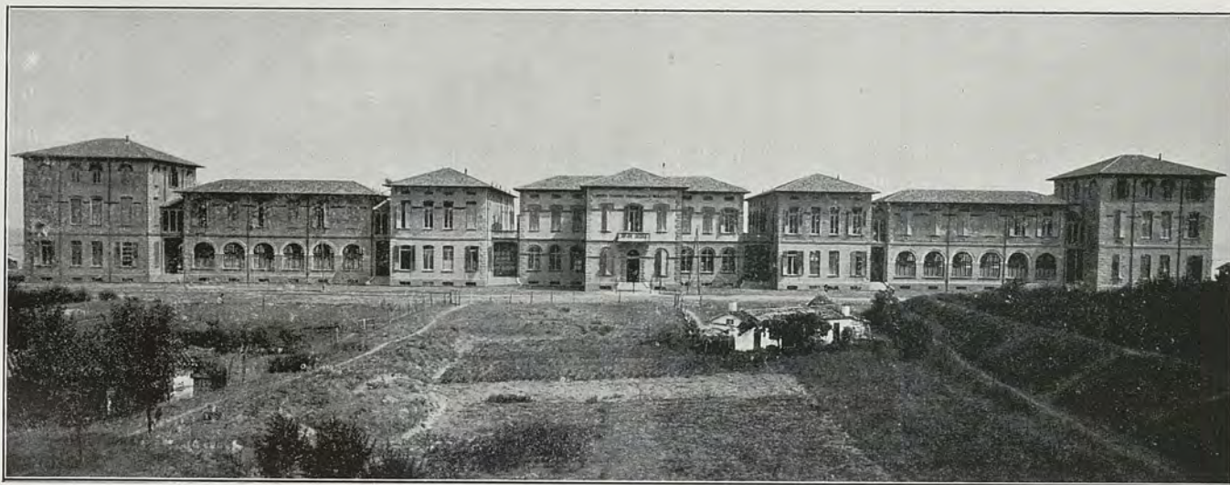
Ospizio Marino Provinciale Bolognese in Rimini. Prospetto verso terra del fabbricato principale.
