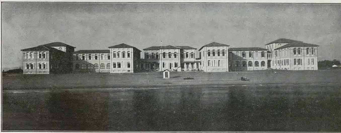
Prospetto a mare del fabbricato principale.
