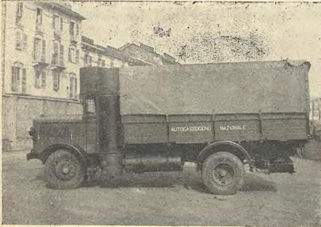
Fig. 5. - Autocarro Fiat 632 G con gazogeno Nostrum.
