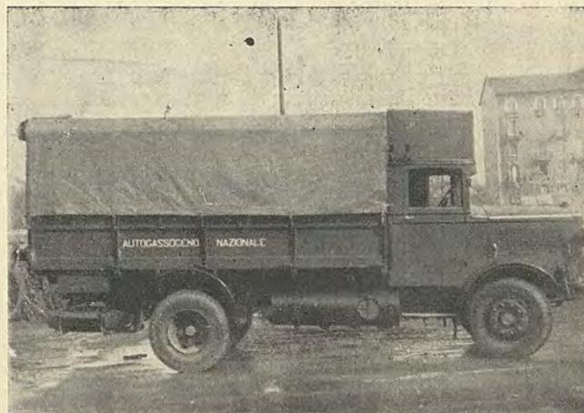
Fig. 6. - Autocarro FIAT 6324 con gazogeno Nostrum
