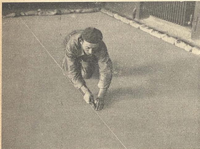
Fig. 3. — Il taglio dei margini sovrapposti, per ottenere un giunto capillare.
