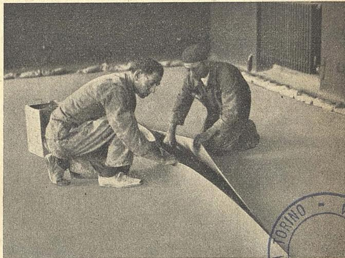
Fig. 2. — L'Incollatura dei Giunti fra telo e telo.
