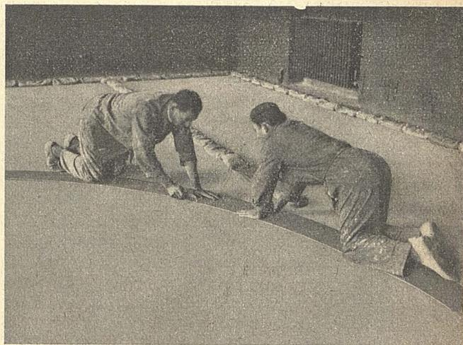
Fig. 5. — *Come si eseguisce l'applicazione di una fascia curvilinea.*
