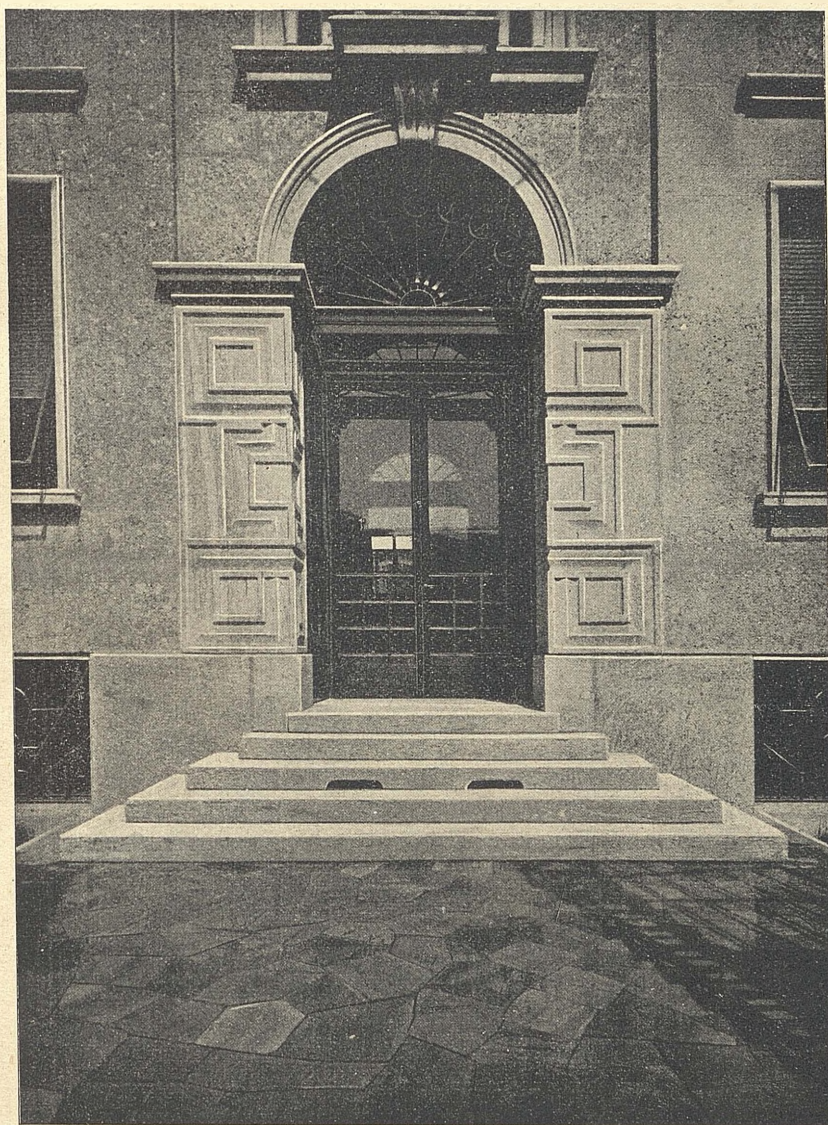
Ospedale Maggiore, Milano: Padiglione Bertarelli in via Pace - Progettista Architetto Sabbioni, Milano APPLICAZIONE DI LASTRE DI QUARZITE AD OPERA INCERTA
