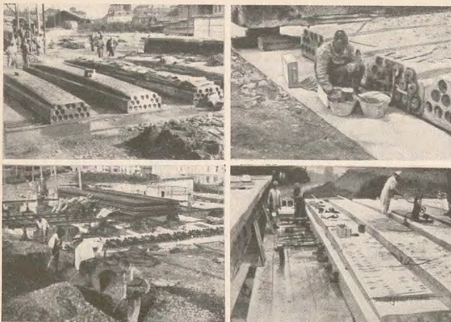
Fig. 19 - 20 - 21 - 22 — Pont de Fribourg.
