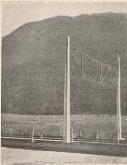
Fig. 15 — Vue d'un pylône de la ligne Auvergnier-Les Verrières.
