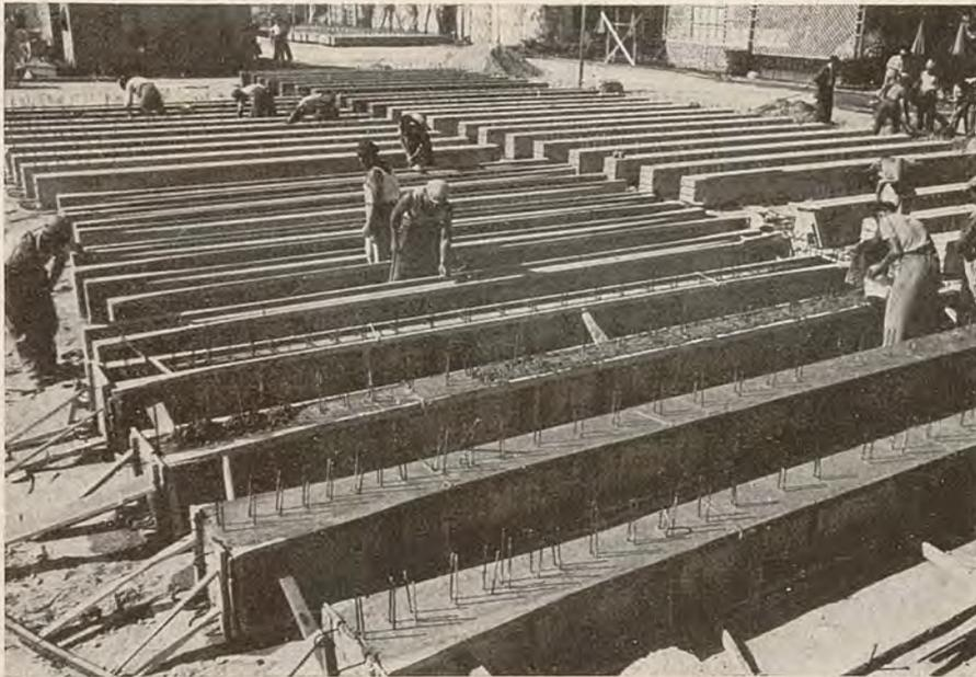
Fig. 9 — Pre-fabbricazione delle travi del solaio.
