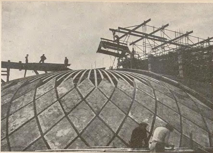
Fig. 8 — Montaggio degli elementi della semicupola. Notare l'armatura in tavole di sostegno.
