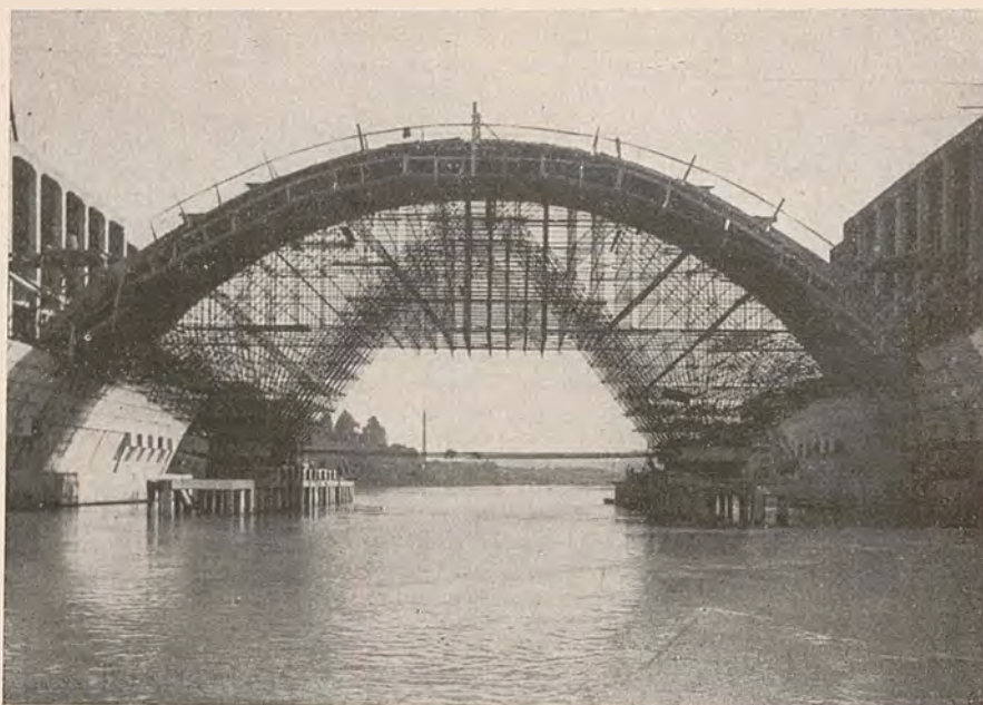
Fig. 7 — Centina tubolare scomponibile per ponte ad arco sul Tevere a Roma, a monte di ponte Milvio. Traslabile lungo l'asse del fiume. Fig. 8 — Centina tubolare scomponibile per ponte a tre travate, sull'Arno a Signa (Firenze). Fig. 9 — Centina tubolare metallica per il viadotto di Seiano (Sorrento-Napoli).
