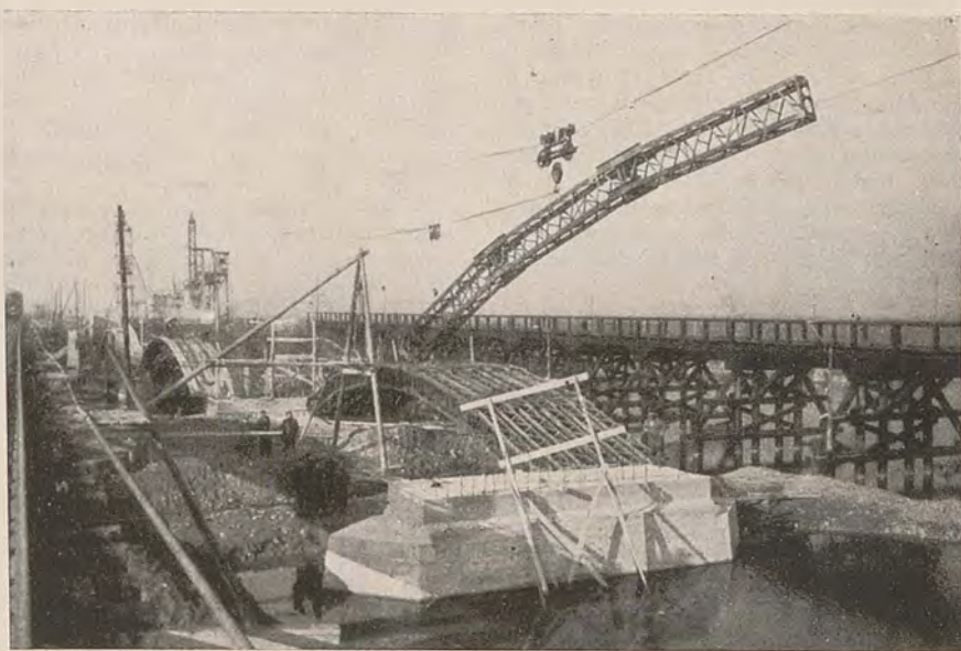
Fig. 4 — Centine metalliche per il ponte ferroviario sull'Orco.
