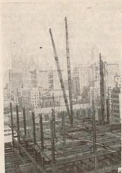
Fig. 1. — Erezione dell'Esso Building di 33 piani mediante una derrick da 16 Tonn. con braccio di 27 metri e colonna alta 30 m.
