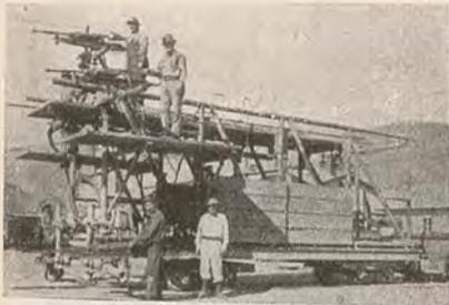
Fig. 14. — Jumbo a 6 perforatrici usato per la galleria dell'acquedotto del Colorado.
