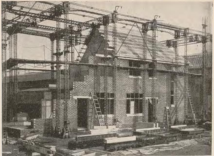
Fig. 11. — Struttura in traliccio per la costruzione di case prefabbricate.
