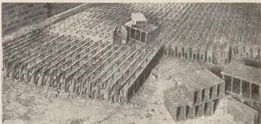
Fig. 4. — Fabbricazione di travetti con casseforme di laterizio incorporate a piè d'opera.
