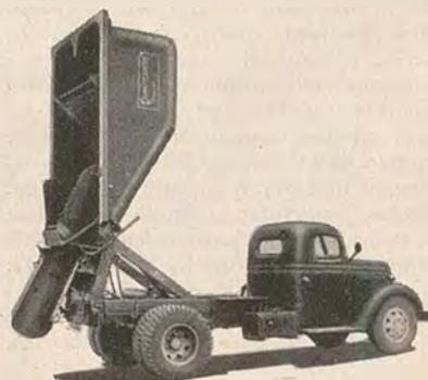
Fig. 11. — Autocarro rapido per il trasporto del beton.
