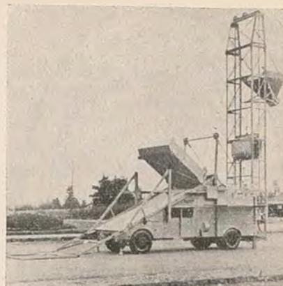
Fig. 9. — Impianto automobile per la produzione e distribuzione del beton.
