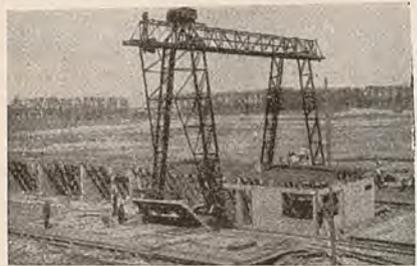
Fig. 10. — Gru elettrica a cavalletto per il montaggio di grandi pannelli murari.
