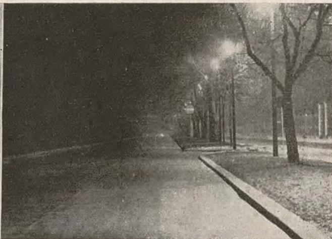
Fig. 7 (a sinistra) — Illuminazione a luce diffusa della strada da Torino a Mirafiori. — Fig. 8 (a destra) — Strada a luce diffusa con ottima visibilità, (fattore di uniformità di brillantezza 0,33) e brillantezza media moderata  $0,57 \text{ cd/m}^2$
