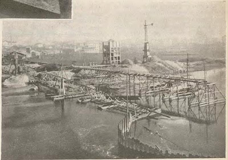
Fig. 4 - Formazione di un isolotto a distanza con il materiale estratto con le pompe dalla spalla. a battente sufficiente per l'impiego della pompa (cioè a metri 2,5 sotto il livello dell'acqua). Tengasi inoltre presente che dall'impiego della pompa consegue la minore durata dell'esecuzione dei lavori di scavo, che si riduce a circa la metà di quella necessaria con l'impiego dei mezzi normali. È in istudio un'altra pompa che consentirà lo scavo anche a cielo libero!
