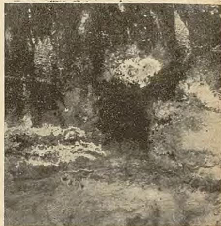
Fig. 6 - Dettagli dell'alterata superficie d'intradosso delle volte del ponte di Via Cigna. Fioriture.
