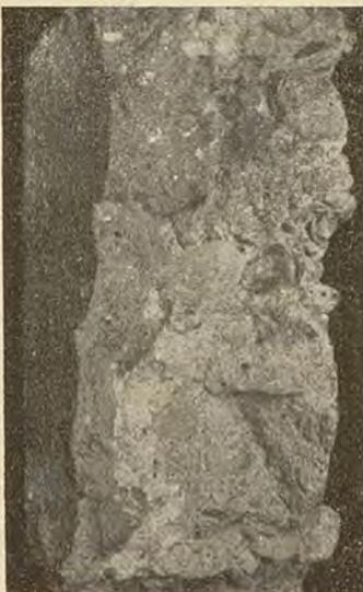
Fig. 2 - Aspetto cavernoso del calcestruzzo del ponte del Colombaro.
