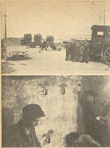
Fig. 13. — Come è stato realizzato il carico mobile: tre carrelli cortissimi affiancati (del peso complessivo di 35,82 tonn.) trainati da un autotratteore stazionante fuori del ponte. Sono visibili gli scavi operati nella massicciata stradale per collocare gli estensimetri sull'estradosso della struttura e la botola per introdursi nell'interno del ponte cellulare.
