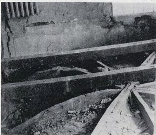
Fig. 10 - La Villa: struttura a centina di una volta, messa in luce dalla demolizione del pavimento soprastante.
