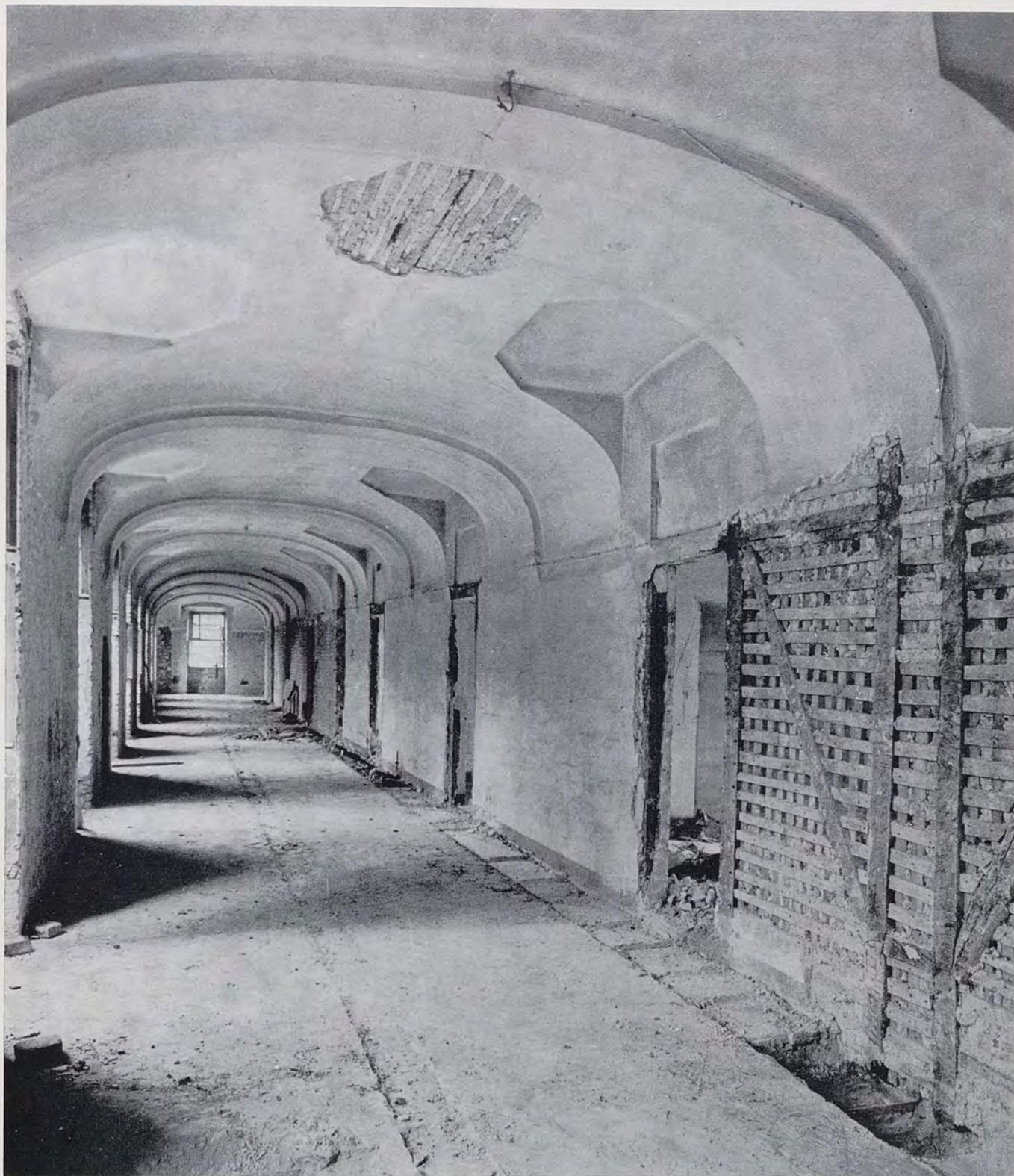
Fig. 10 - Il corridoio al terzo piano, durante i lavori: si notino i graticci lignei di tamponamento sia verticale, sia della volta.
