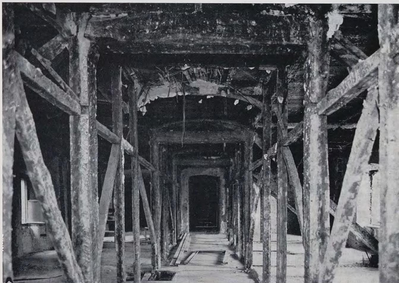
Fig. 13 - La struttura lignea al quarto piano, liberata dal rivestimento, prima della demolizione.
