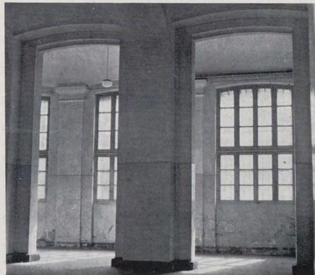
Fig. 2 - La struttura delle quattro maniche dell'edificio: pilastri, archi e volte in muratura.
