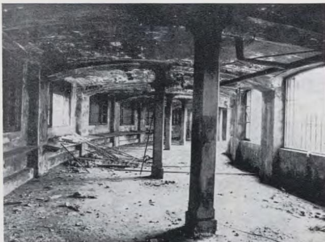
Fig. 3 - Le manomissioni riscontrate nell'edificio: in corrispondenza della mezzeria degli archi sono stati inseriti pilastri in cemento armato con conseguente comparsa di lesioni.
