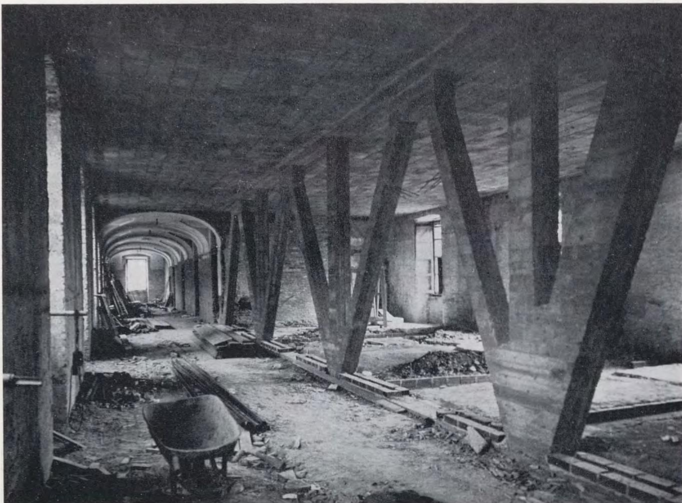
Fig. 14 - La struttura sostitutiva in c.a. al terzo piano, prima dei tamponamenti.
