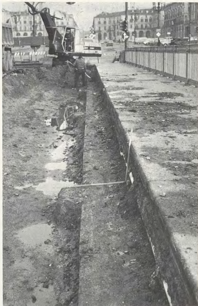
Fig. 3, 4 - Ponte Vittorio Emanuele I, profili del marciapiede originale del ponte: si notano i cordoli di basamento delle lastre di pavimentazione e dei paracarri.
