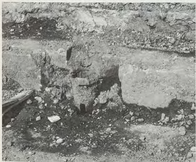
Fig. 5, 6 - Ponte Vittorio Emanuele I, doccioni originali in ghisa. Si noti uno dei tre fori a livello della cappa per lo smaltimento delle acque d'infiltrazione. Sul marciapiede è posato un blocco rimosso, cui è ancora unito uno degli imbocchi flangianti dei doccioni (il pezzo è ora al Magazzino comunale di via Varano).
