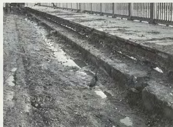
Fig. 3, 4 - Ponte Vittorio Emanuele I, profili del marciapiede originale del ponte: si notano i cordoli di basamento delle lastre di pavimentazione e dei paracarri.
