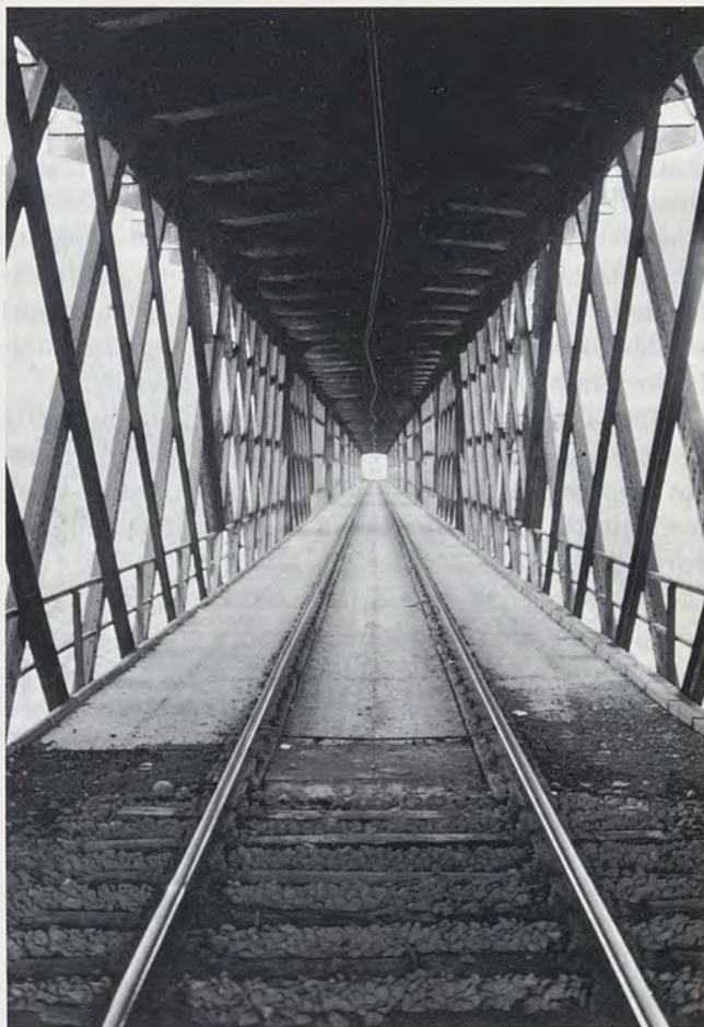
Ponte di Paderno; la trave continua di 260 m, con struttura a cassone reticolare è ad uso promiscuo: sopra la strada, sotto la ferrovia.
