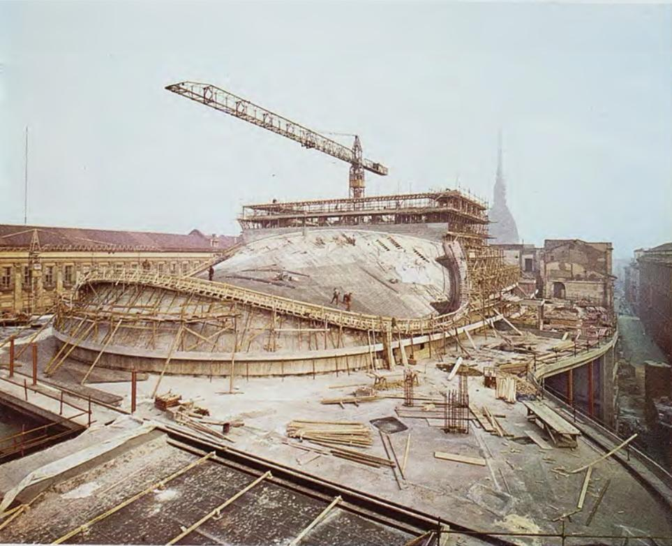
*Tettoia delle contrattazioni nel nuovo Mattatoio Civico di Torino. La copertura centrale, della luce di circa 30 m, è realizzata con volte sottili di paraboloidi iperbolico (spessore 6 cm) disposte con generatrici diagonali.*
