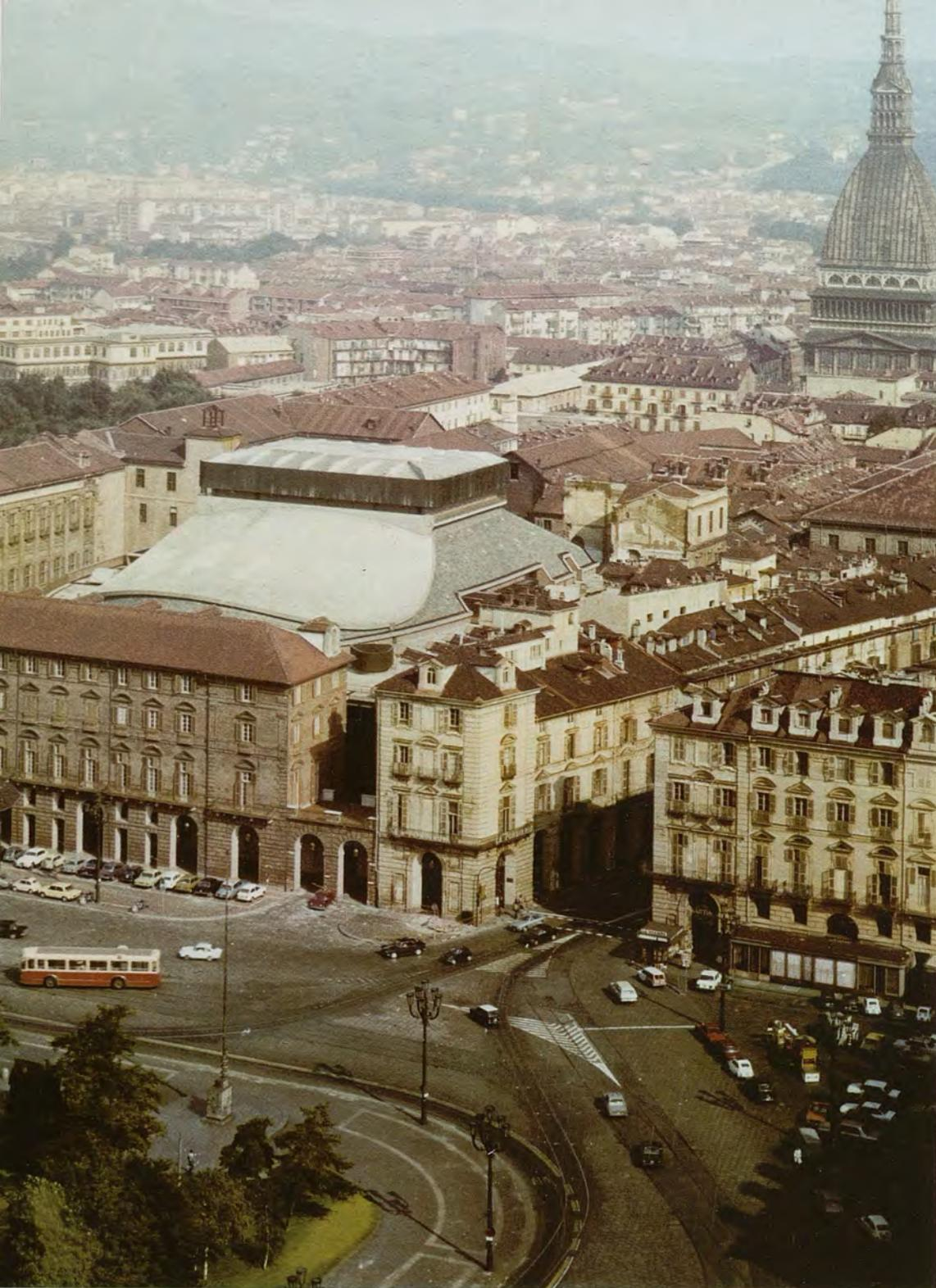
*La copertura della sala, a volta sottile conformata a paraboloide iperbolico e la copertura della torre di scena, a cupola nervata, entrambe calcolate e realizzate dall'Impresa.*
