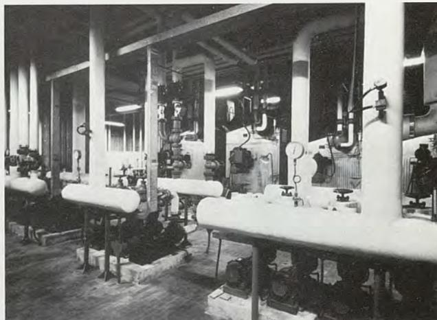
Fig. 11 - Caldaie e collettori di distribuzione nella centrale termica.
