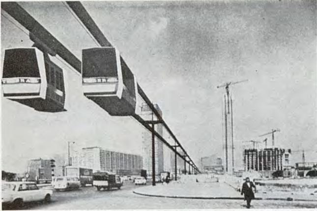
Fig. 15 - Fotomontaggio del Telerail.
