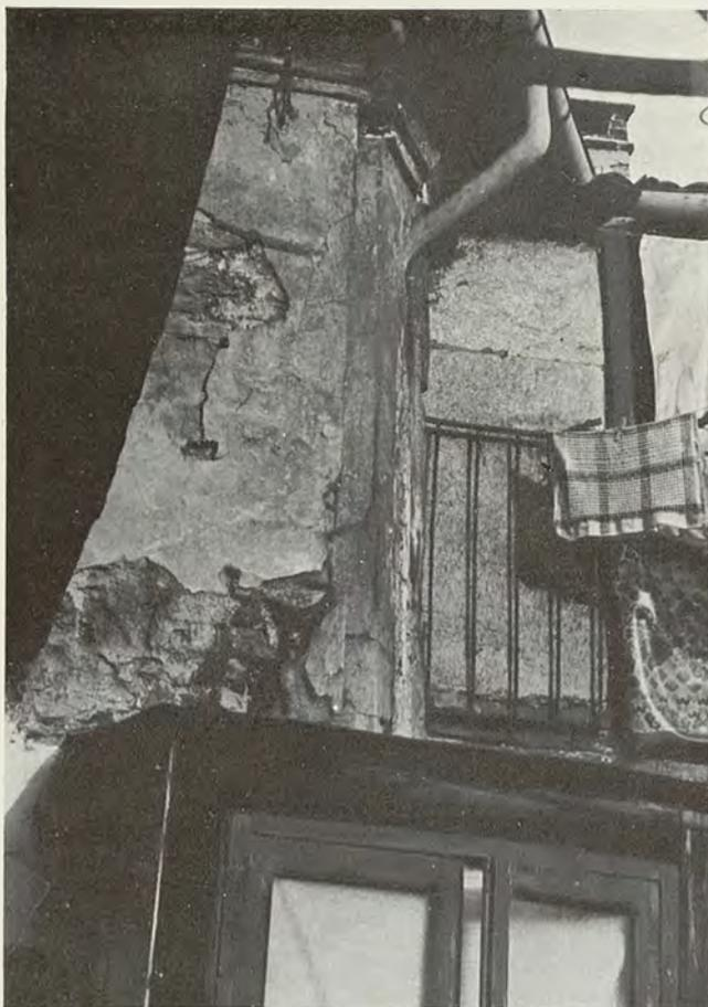
Fig. 5 - Lo stato di faticenza esterna e una lesione con chiave.
