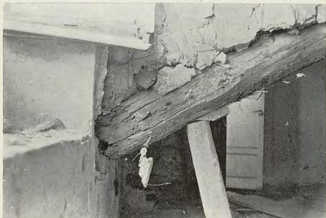
Fig. 16 - Incastro di una trave portante quasi completamente erosa.
