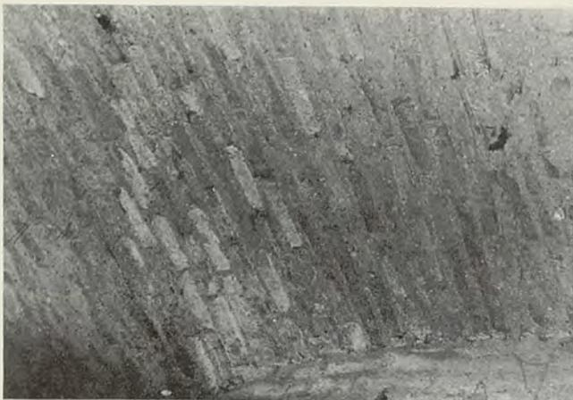
Fig. 4 - Tessitura dei mattoni in una volta del cantinato.
