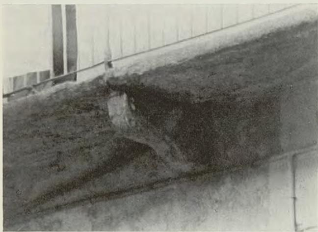
Fig. 11 - Efflorescenze e sfaldatura superficiale delle mensole in pietra.
