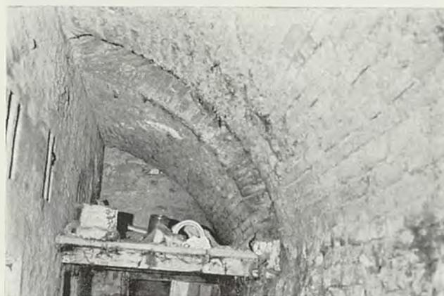
Fig. 3 - Particolare di innesto di una volta nel cantinato.
