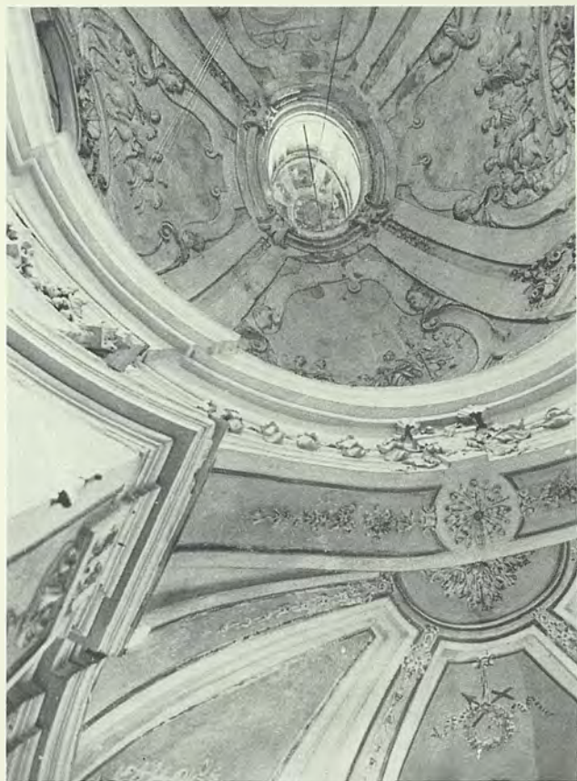
Fig. 8 - Bene Vagienna. Palazzo Magistrati. Cappella dei Tre Re. Particolare dell'arco trionfale. (Foto Dall'Acqua).
