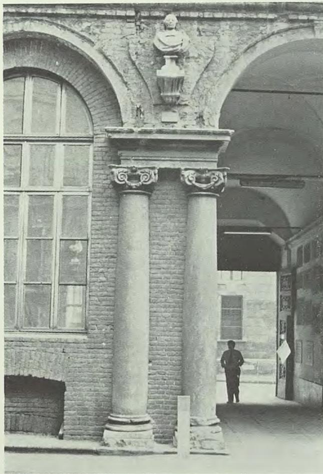
Fig. 3 - Sistema trabeazione-colonne oggetto d'indagine statica.
