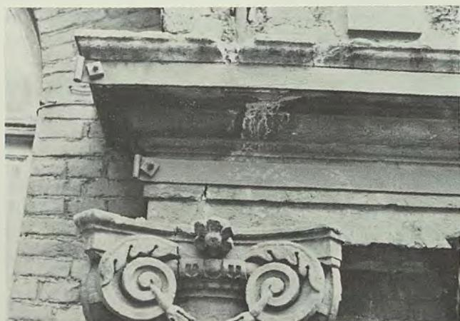
Fig. 4 - Stato fessurativo nel sistema trabeazione-capitello.
