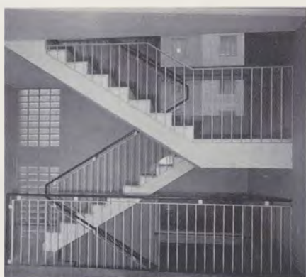
Particolare della scala
