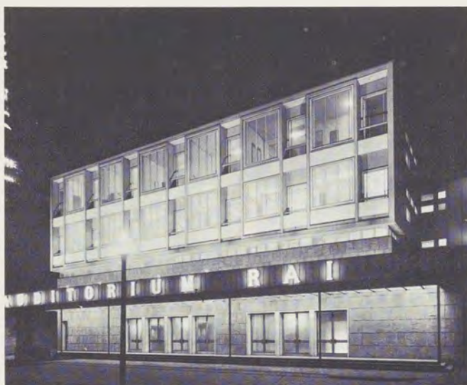
La facciata principale, ripresa dalla piazzetta antistante
