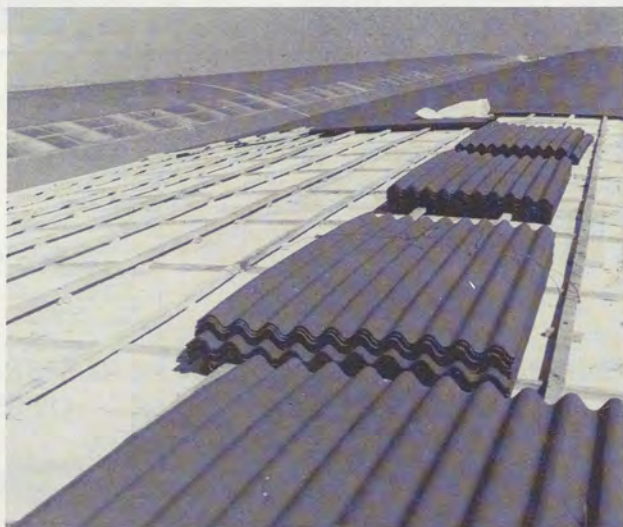
La lastra ONDULINE fra gli altri suoi attributi ha il merito di essere facile da posare in quanto richiede una semplice struttura di fissaggio. Può essere sufficiente un solo operaio anche non specializzato per posare le lastre. È questo un vantaggio economico di grande valore.
