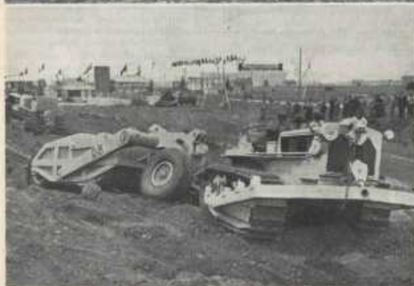
Fig. 6. - Trattrice FIAT 55 L con ruspa Giovannetti. Fig. 7. - Trattrice Breda con ruspa CIR R 6. Fig. 8. - Trattrice Ansaldo AF 8 con ruspa CIR R 8.
