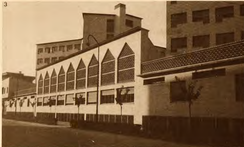
3. Pensionati dell'Università Bocconi, Milano, 1953-55: veduta del fronte su Via Toniolo con il corpo in linea dei servizi collettivi. 4. Chiesa di S. Antonio, Varese, 1955: veduta generale.
