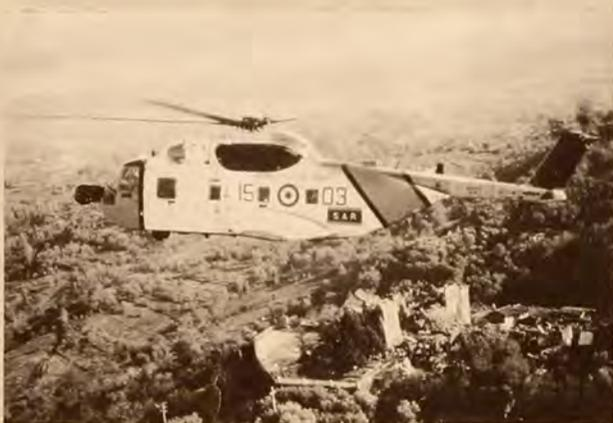
*L'HH-3F, realizzato per assolvere missioni di ricerca e salvataggio, possiede un'autonomia di volo di oltre sette ore ed è in grado di perlustrare 21.000 miglia quadrate nel corso di una sola missione senza rifornimento.*
