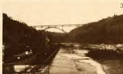
1. Granaio adibito a bigattiera sullo scorcio del XIX sec., Aversa (NA). 2. G. Mengoni, Galleria Vittorio Emanuele, Milano, 1867. 3. Röh-
