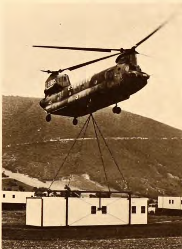
Un elicottero birotore EMB CH-47C Chinook dell'Esercito Italiano nel corso di operazioni di protezione civile in Irpinia, in occasione del terremoto. Il Chinook può agevolmente sollevare carichi del peso di oltre 9 tonnellate, trasportare 44 militari con equipaggiamenti di soccorso, oppure una unità ospedaliera ESFC.
