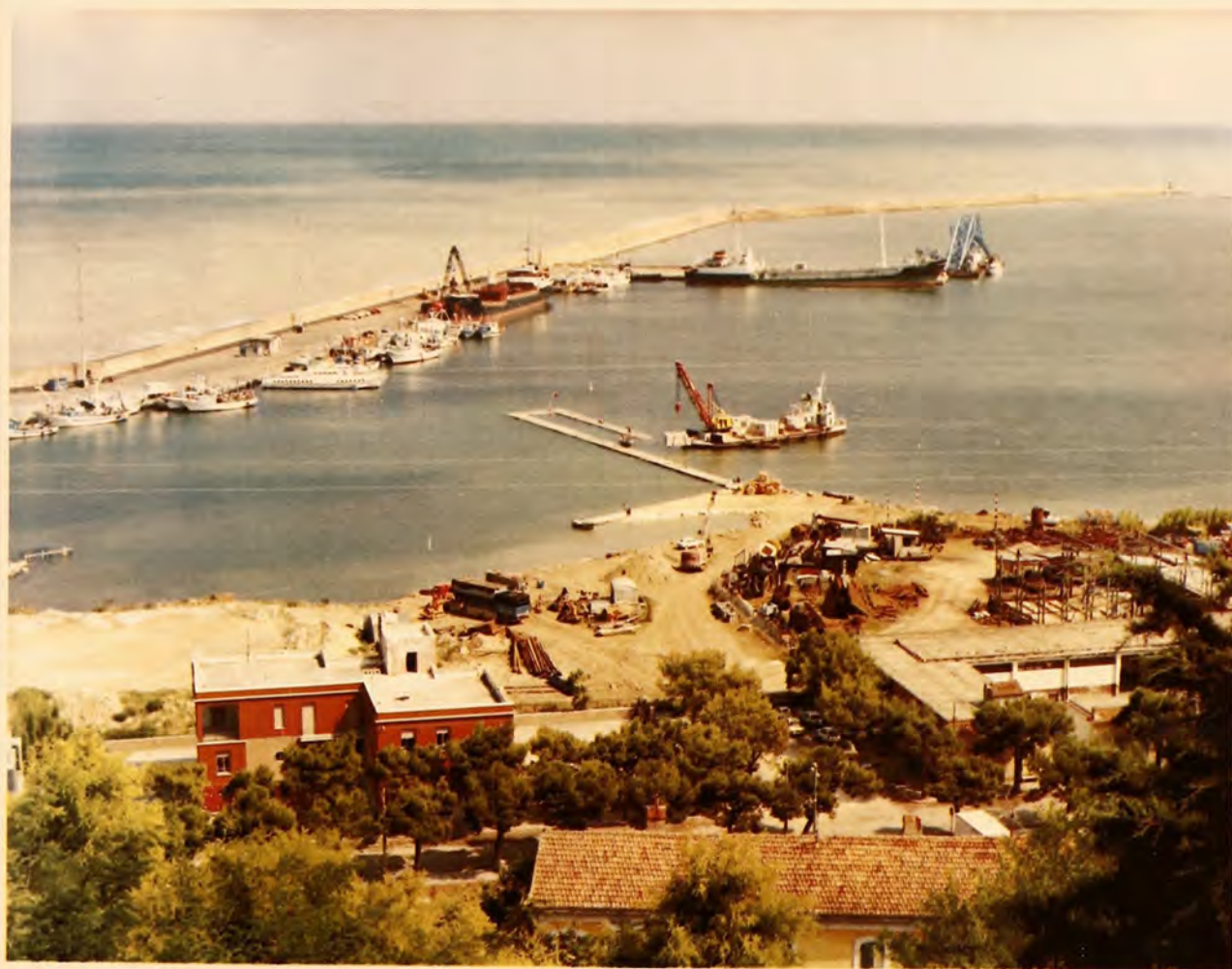
Porto di Ortona - Lavori di escavazione e costruzione dell'approdo per naviglio minore del porto di Ortona
