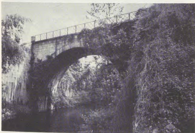
Fig. 21 - Ponte ad arco in blocchi di granito sul canale Nigoglia ad Omegna.
