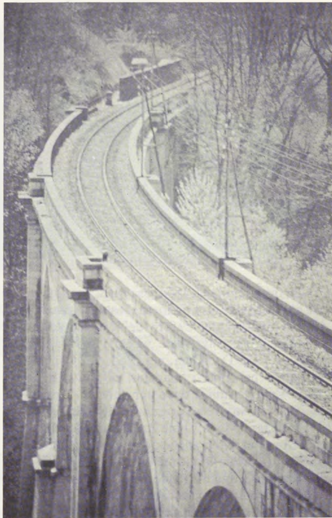
Fig. 15 - Il viadotto in curva di Pettenasco, gettato sulla valle del Pescone negli anni 1884-1886 dall'impresa Visconti e Galegari, su progetto dell'ing. Oreste Mugnaini, ad otto arcate a pieno centro di 16 m di luce.
