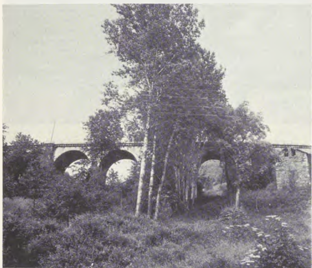
Fig. 20 - Il viadotto della valletta di Crabbia, a dieci arcate multiple in blocchi di granito.
