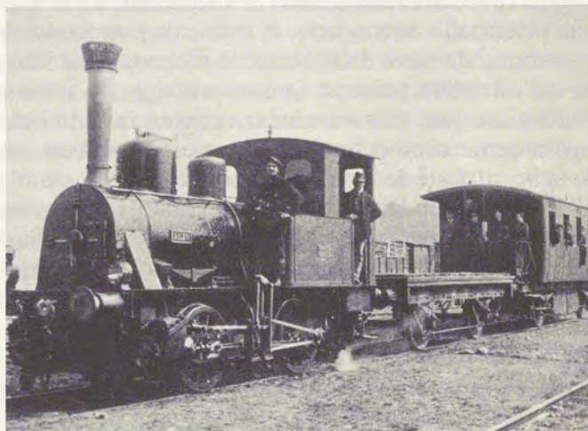
Fig. 13 - Stazione della Rete Mediterranea di Gozzano. Il tronco Novara-Gozzano fu inaugurato nel 1864. Solo venti anni più tardi sarebbe stato aperto il tronco Gozzano-Orta, a seguito dell'approvazione della «linea di accesso al Sempione da Gozzano a Domodossola», linea che fu qualificata «complementare di seconda categoria».
