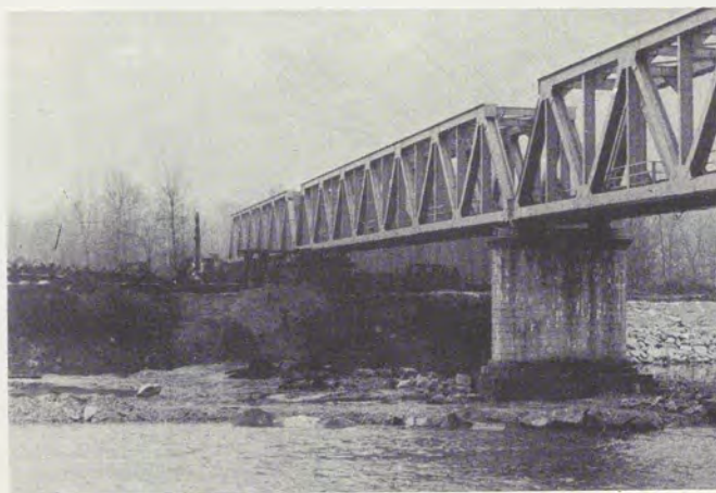
Fig. 18 - Ponte sul fiume Toce a Migiandone. La nuova sovrastruttura è stata impostata sulle pile in granito del ponte originario.
