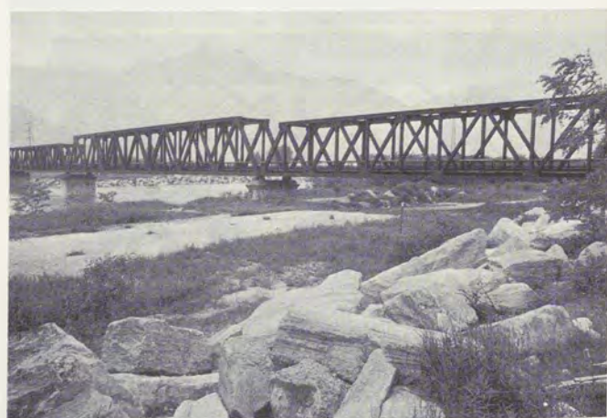
Fig. 32 - Il ponte sul Toce e il viadotto sussidiario verso Domodossola sono stati sostituiti nel 1974 con ponti a travi principali a grandi maglie triangolari impostate sui piloni originari.
