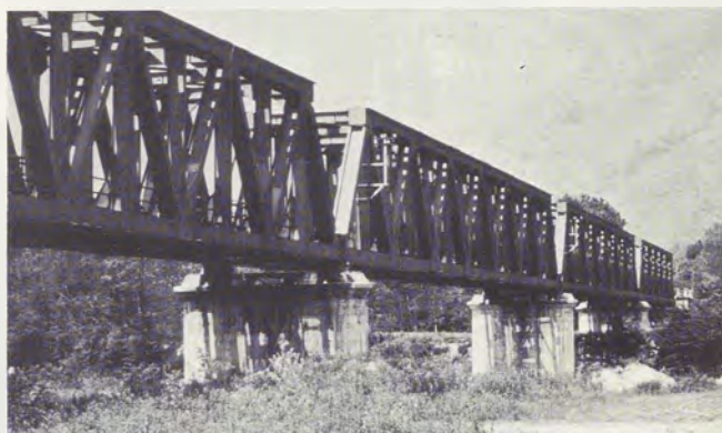
Fig. 26 - Il ponte sul Toce a Migiandone, a sette travate, di luci variabili tra i 68 m e i 56 m. Il ponte originario in una foto di fine Ottocento e il ponte attuale.
