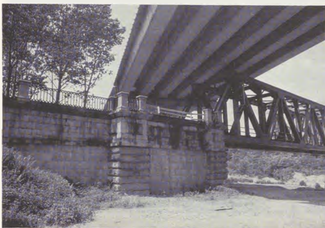
Fig. 29 - L'innesto della nuova sovrastruttura sulla spalla del ponte originario sulla riva destra del Toce.
