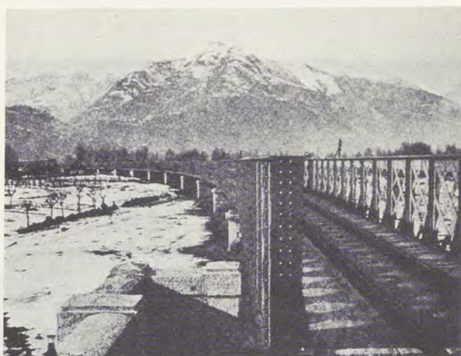
Fig. 30 - Il viadotto in curva a due travate indipendenti, facente parte dell'attraversamento del fiume Toce a Vogogna (disegno e foto d'epoca).
