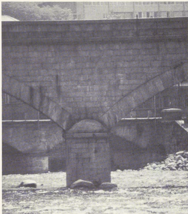
Fig. 22 - Ponte a tre luci ad arco ribassato in blocchi di granito sul torrente Strona ad Omegna. Particolare dell'innesto delle arcate su di una pila intermedia.
