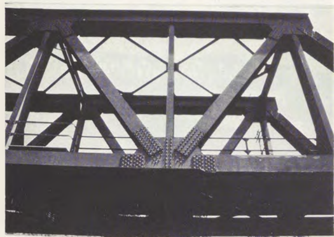
Fig. 28 - Dettaglio della trave a larghe maglie triangolari dell'attuale ponte di Migliandone.
