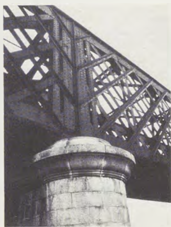
Fig. 18 - Ponte sul fiume Toce a Migiandone. La nuova sovrastruttura è stata impostata sulle pile in granito del ponte originario.
