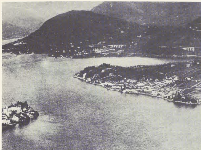
Fig. 19 - Il lago d'Orta con l'immagine di un tratto della riviera da Orta a Crabbia, da una fotografia dell'inizio del secolo. Si riconoscono, sullo sfondo, i viadotti di Pettenasco e della Sassina, ad arcate multiple in blocchi di granito.
