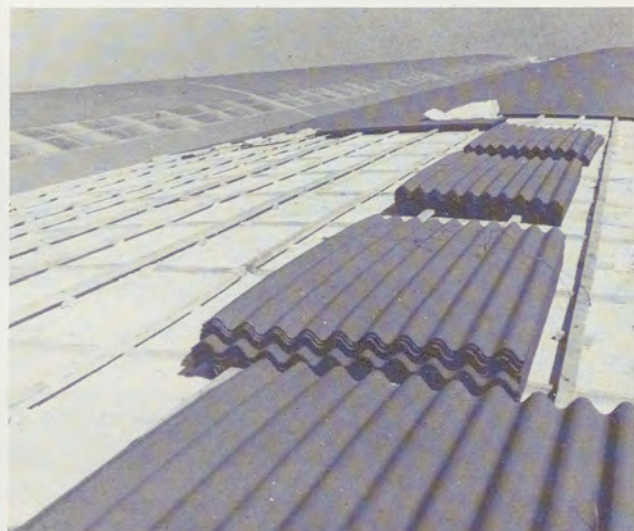
La lastra ONDULINE fra gli altri suoi attributi ha il merito di essere facile da posare in quanto richiede una semplice struttura di fissaggio. Può essere sufficiente un solo operaio anche non specializzato per posare le lastre. È questo un vantaggio economico di grande valore.
