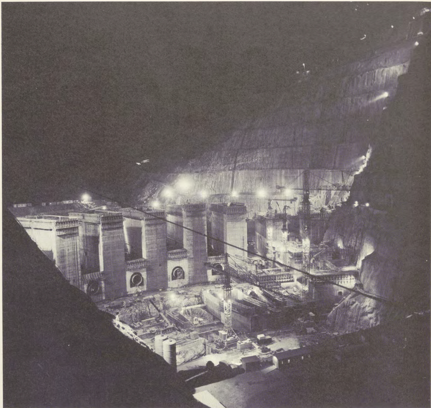
TURCHIA - DIGA DI KARAKAYA - ITALSTRADE RECCHI
